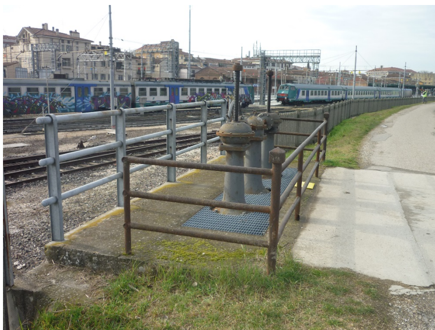
Figura 3-2: Paratoia di regolazione posta a valle della chiavica.
