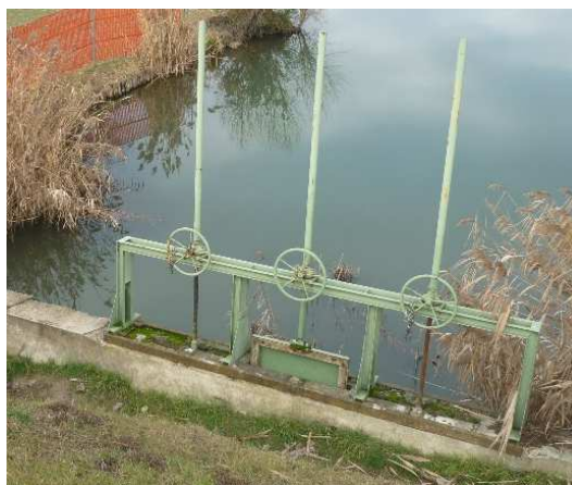
Figura 4-4: 9 febbraio 2018. Chiavica Rio di Mantova. Si nota il diaframma della paratoia centrale aperta.
