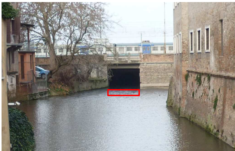
Figura 4-2: Sezione di sbocco del tratto tombinato d'attraversamento della S.P.10. In rosso sezione di misura della portata.
