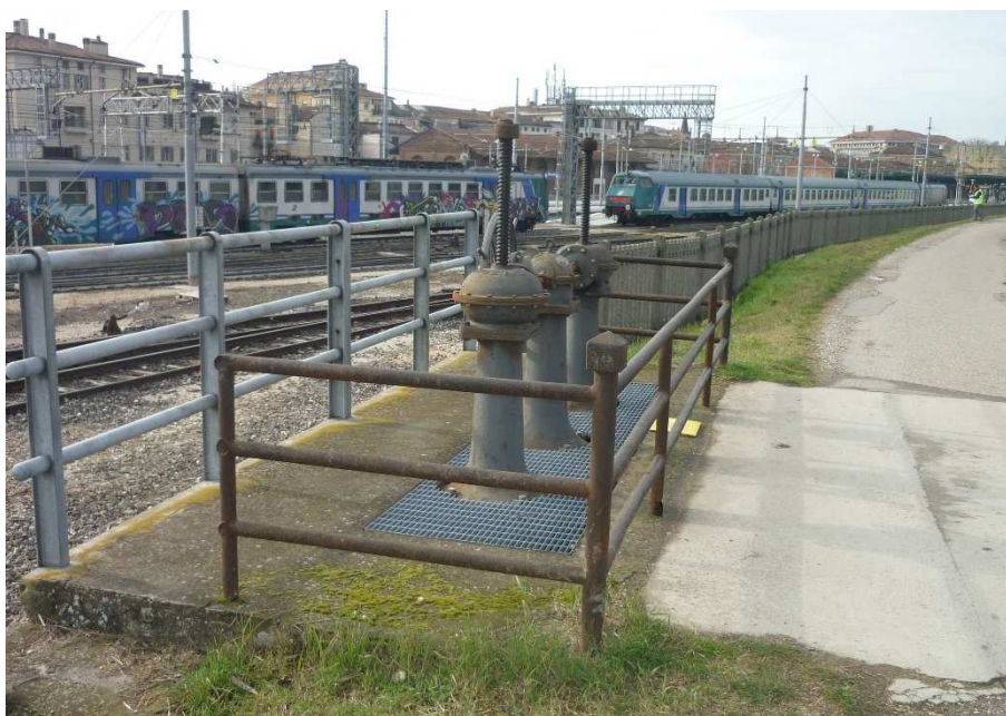
Figura 5-1: Paratoia di regolazione posta a valle dell'attraversamento della ciclabile. Vista dell'organo di comando.
