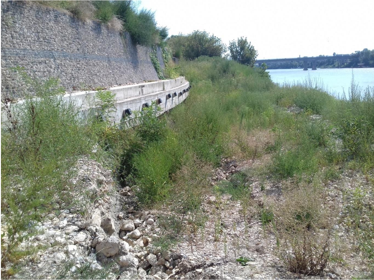
Figura 1 - Cedimento banchina Polesella visto da monte
