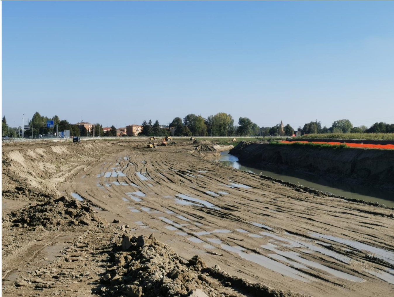
Fiume Secchia: tratto arginato da valle cassa di espansione al confine regionale
