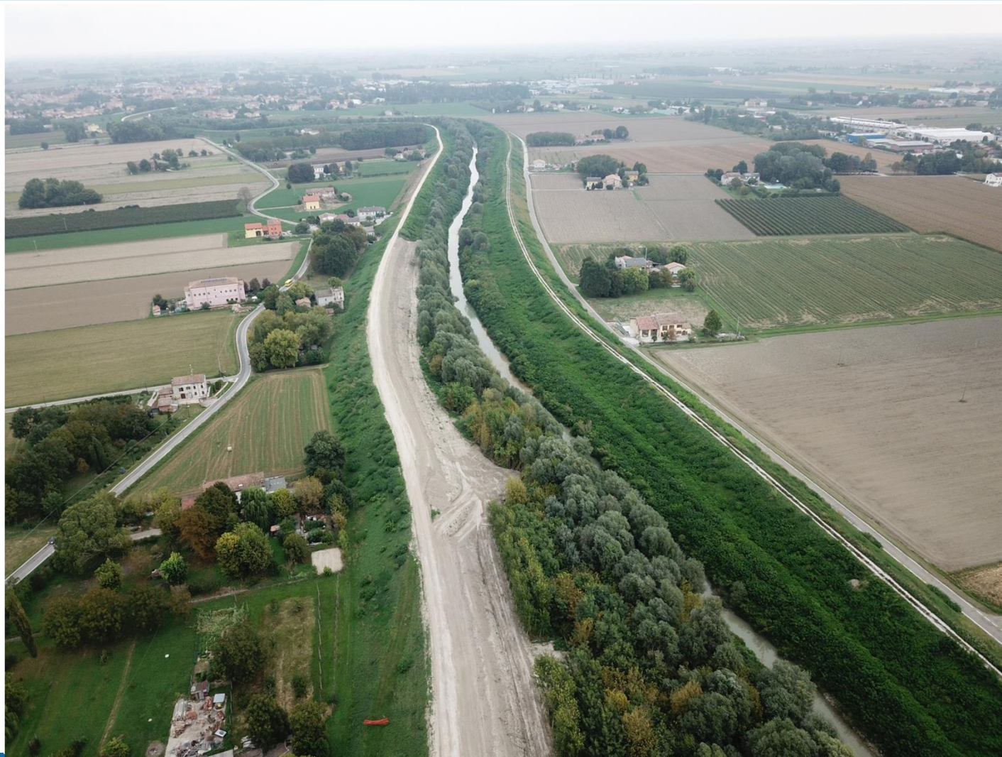
Fiume Secchia: tratto arginato da valle cassa di espansione al confine regionale
