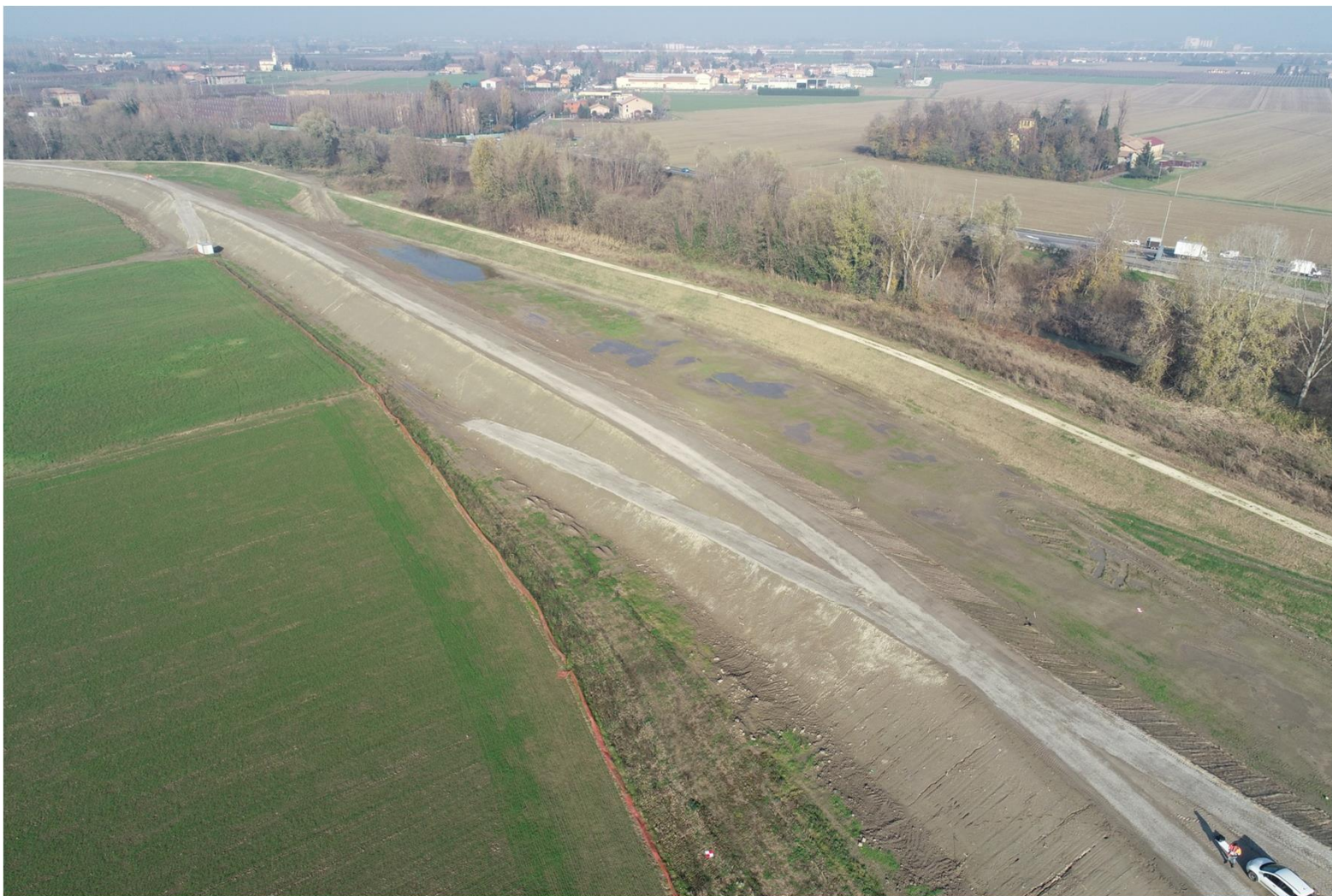
Fiume Secchia: tratto arginato da valle cassa di espansione al confine regionale
