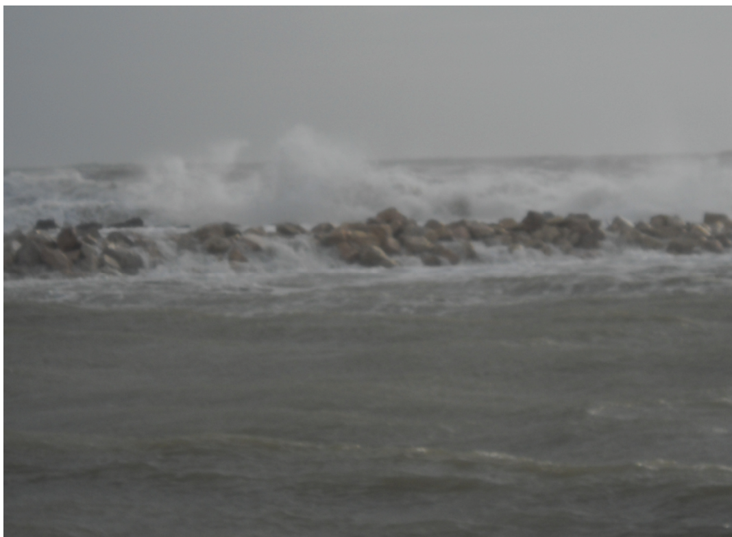
Fig. 2 - Mareggiata del 11.11.2012 in località Barricata – in evidenza l'effetto di attenuazione del moto ondoso indotto da una scogliera frangiflutti (locale molo foraneo).
