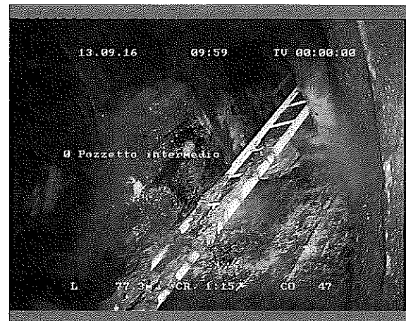
Fotografia: 1_2A 77,36m, 0 Pozzetto nascosto 101 BIS (CON SALTO DI QUOTA)
