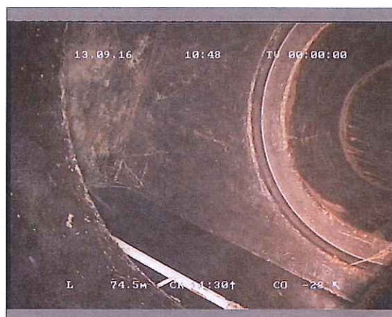
Fotografia: 2_2A 74,58m, 0 Pozzetto intermedio 100 (CON SALTO DI QUOTA)
