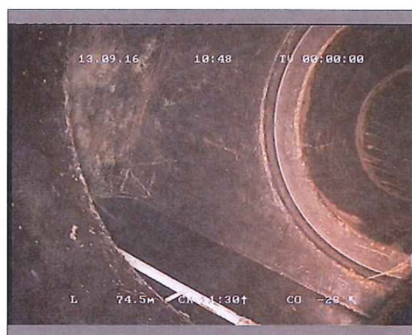
Fotografia: 2_2A 74,5m, Ø Pozzetto intermedio 100 (CON SALTO DI QUOTA)
