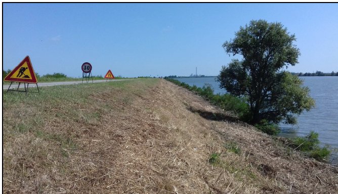
Immagine rappresentativa dell'attività di pulizia preventiva della vegetazione con mezzi meccanici
