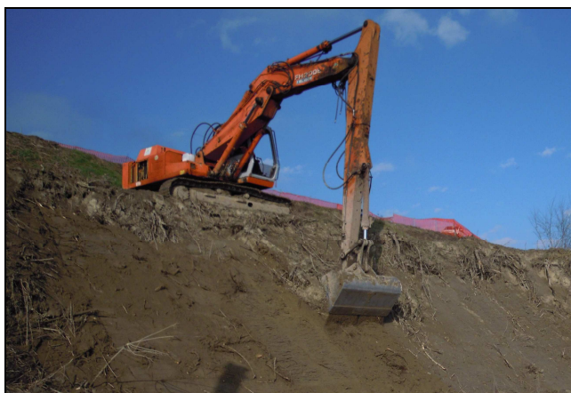
Immagine rappresentativa dell'attività di regolarizzazione della scarpata
