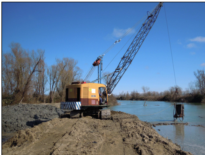
Immagine rappresentativa dell'attività di scavo con mezzo posizionato a terra
