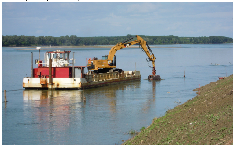
Immagine rappresentativa dell'attività di scavo con mezzo imbarcato su moto-pontone
