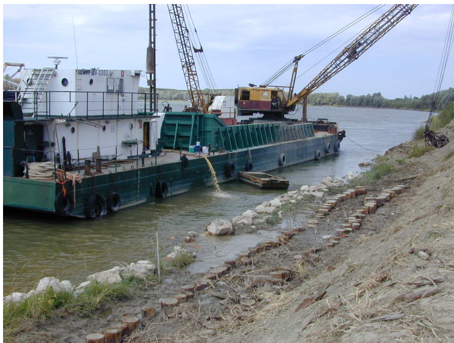
Figura 14 - Particolare della palificata in legno realizzata nell'anno 2003 nell'ambito dell'intervento di classifica RO-E-1382 "Lavori di somma urgenza per la messa in sicurezza dell'arginatura maestra in sinistra Po fra gli stanti 354-355 – IV T.C. nel comune di Guarda Veneta"- posizionamento della palificata al piede di frana.
