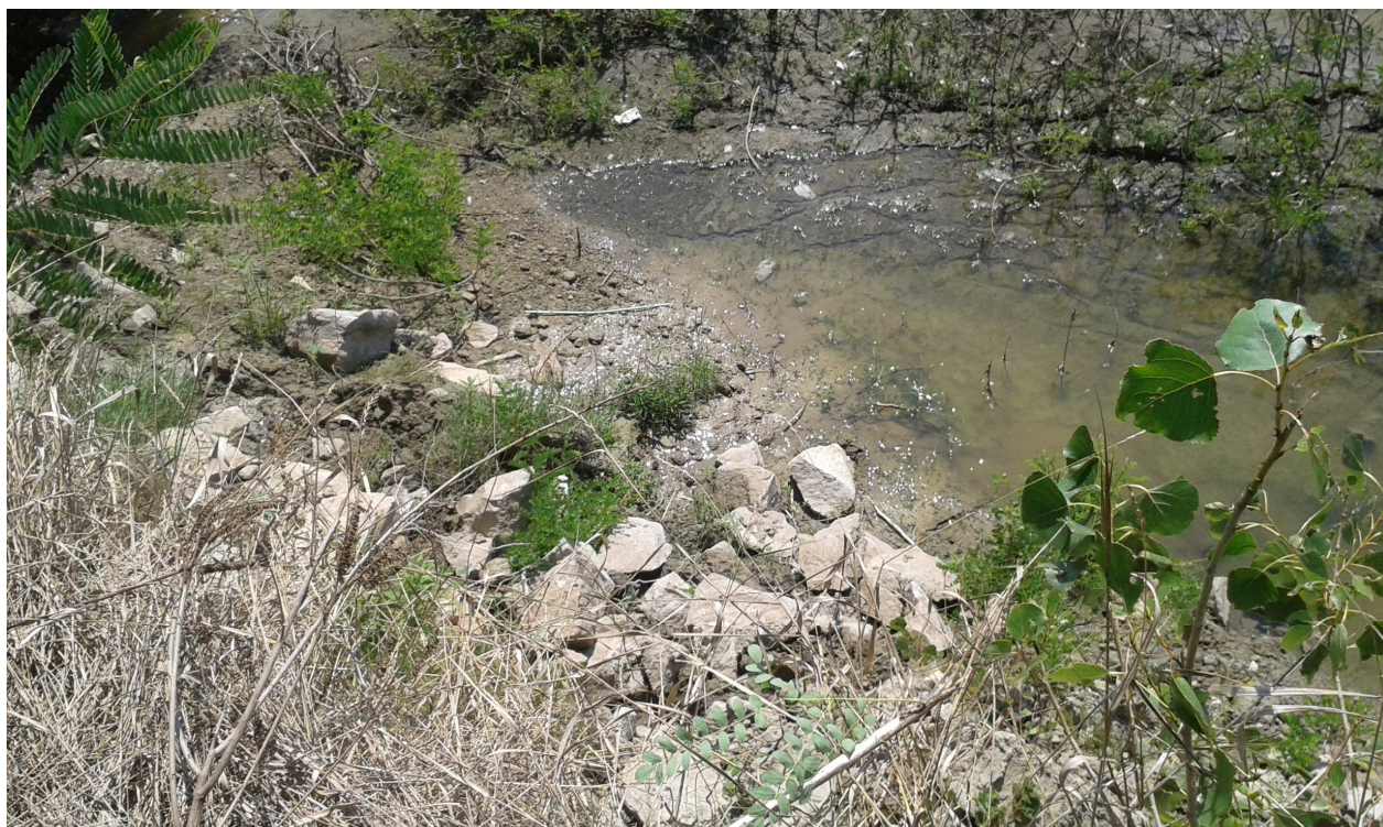
Figura 12 – Tratto di sponda in sinistra idraulica interessato dal presente progetto di manutenzione – Ficarolo (RO) – stanti 163-164 – Particolare dell'emergenza della falda freatica al piede della scarpata di sponda in condizioni idrometriche di magra del fiume (Luglio 2018).
