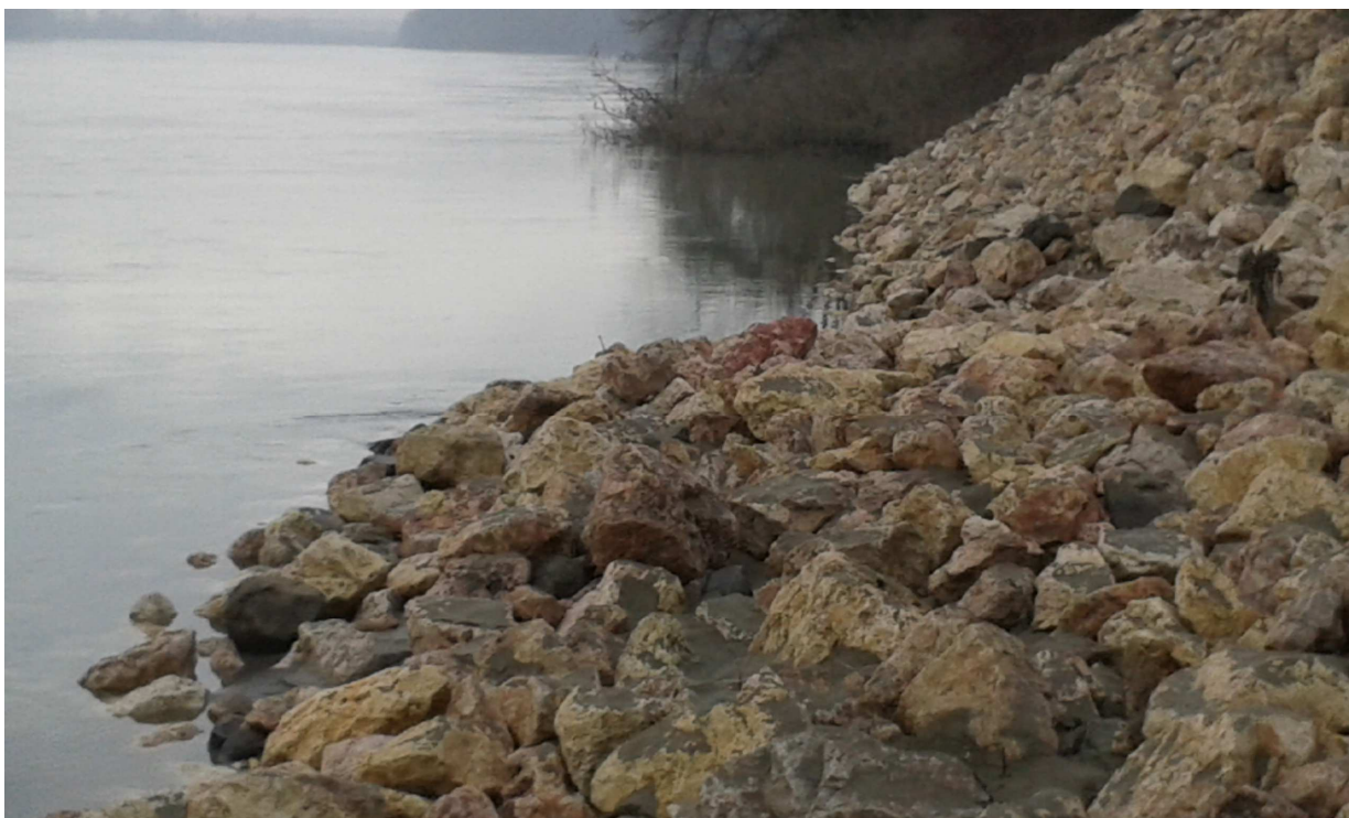
Figura 3 – situazione a febbraio 2018 – particolare del piede di frana (parte fuori acqua)
