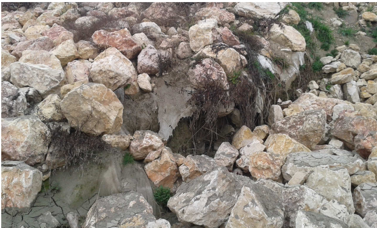
Figura 2 – situazione a febbraio 2018 – il movimento ha determinato la rottura del geotessuto posto sotto il pietrame.
