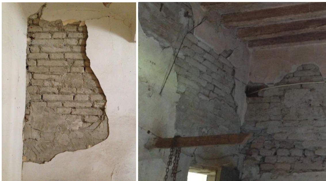
Tessitura tipica della muratura in laterizio
