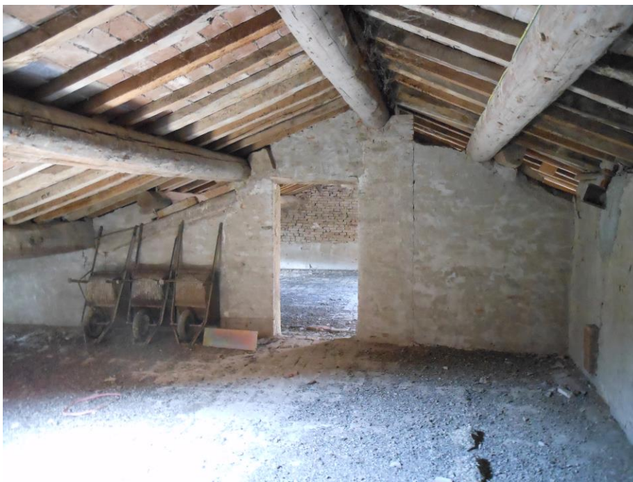
Solaio di copertura con terzere, travetti e pianelle
