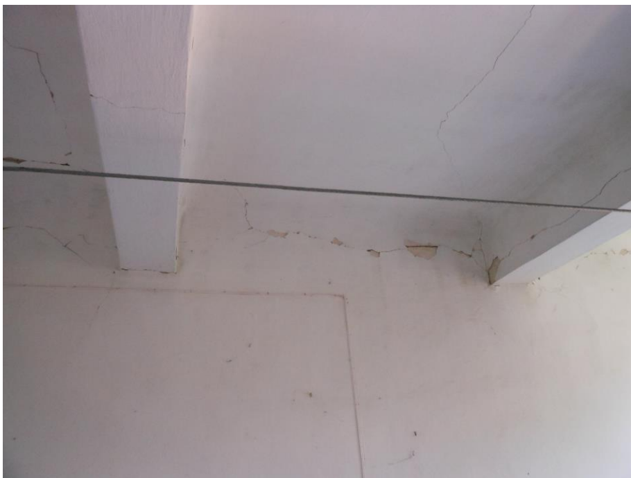
Solaio di piano con doppia orditura lignea e pianelle rivestito con incannucciato
