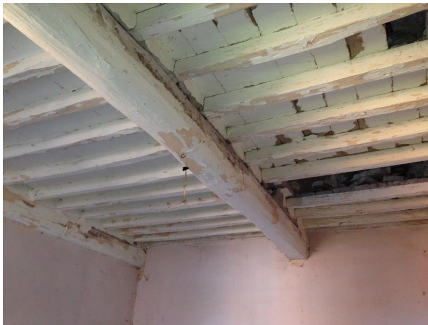
Solaio di piano con doppia orditura lignea e pianelle
