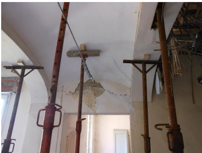
Puntellatura arconi vano scala piano primo
