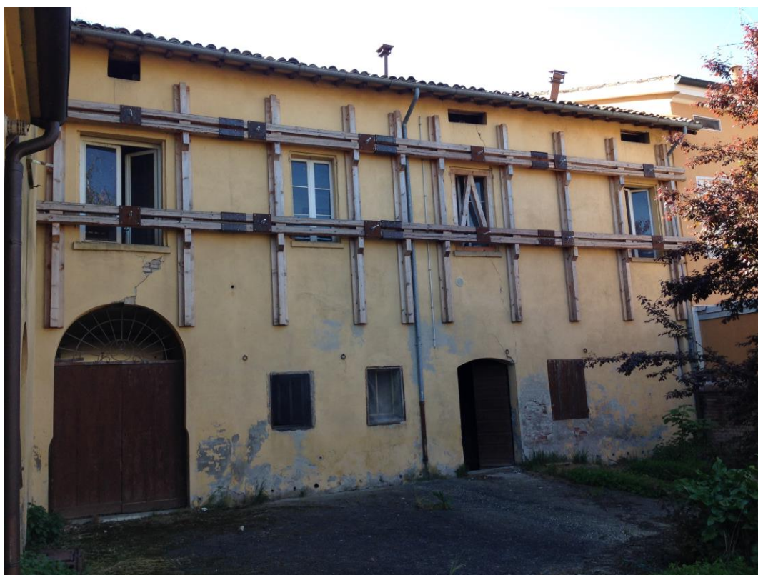
Messa in sicurezza lato cortile interno (facciata est)
