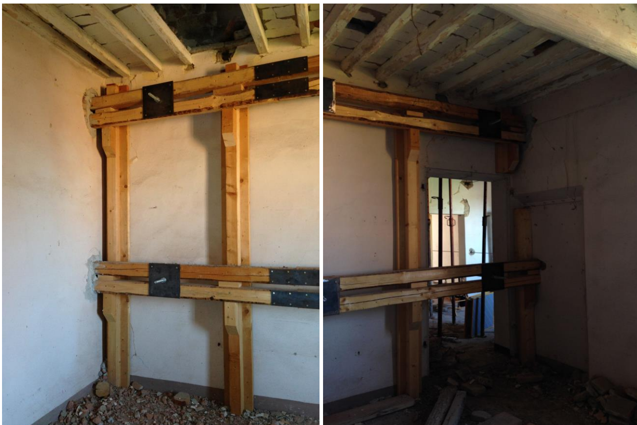
Messa in sicurezza parete interna (prosecuzione dell'intervento sulla facciata est)
