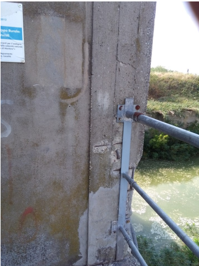
Prospetto ovest – Pilastro del telaio con copriferro crollato ed in via di distacco
