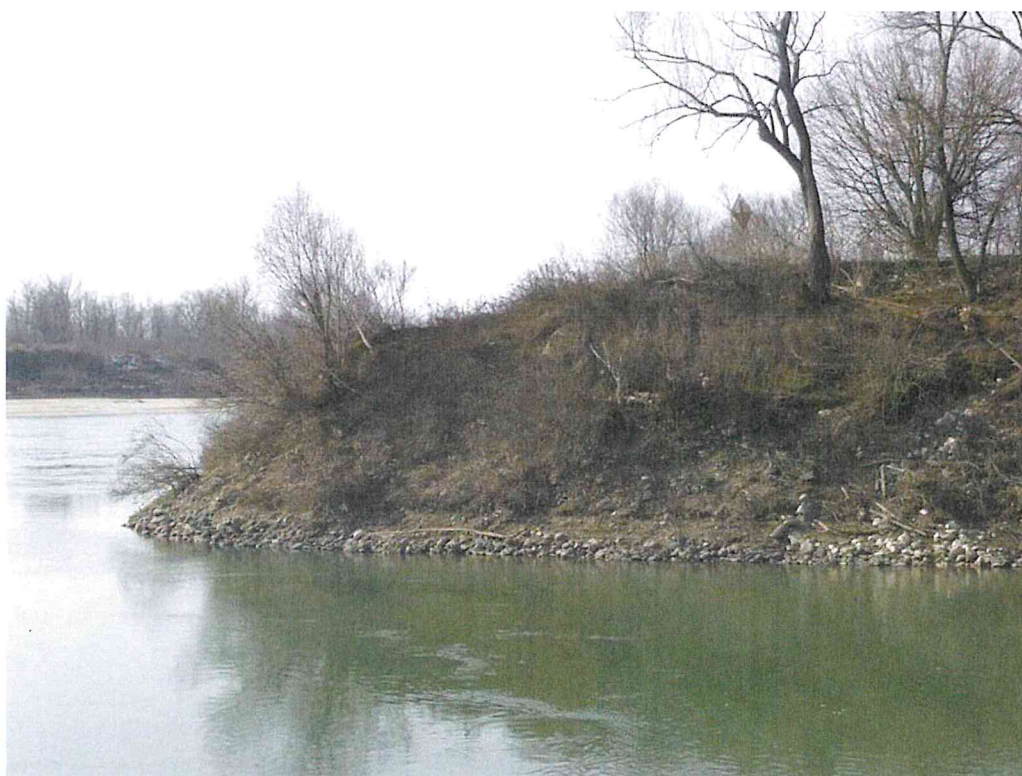
Foto: 10 – dissesto sponda sinistra della avanconca in corrispondenza dell'imbocco del canale
