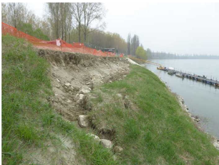
Foto 1: dissesto spondale presente a valle dell'immissione del canale Fossetta nel fiume Po.
