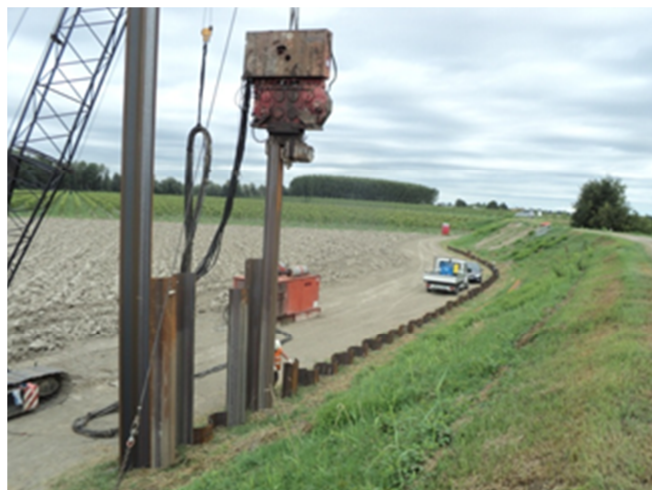
Fig. 7 Intervento di sostegno e diaframmatura del rilevato arginale con palancoleto metallico (intervento eseguito in loc.tà loc. Cavezzo - Via Bozzala)
