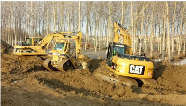
Figura 32. Inizio dei lavori di ripristino dell'argine sormontato del Torrente Enza – 13/12/2017.
