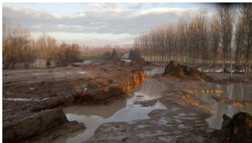
Figura 31. Tratto arginale interessato dalla rotta, al termine dell'esondazione. Argine destro T. Enza all'altezza dell'abitato di Lentigione.
