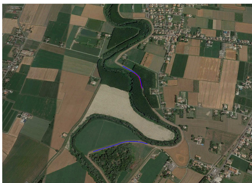
Figura 28. Planimetria dell'area interessata dalla rotta arginale. In blu i tratti sormontati con gravi danni al paramento arginale a campagna e in rosso il tratto della rotta
