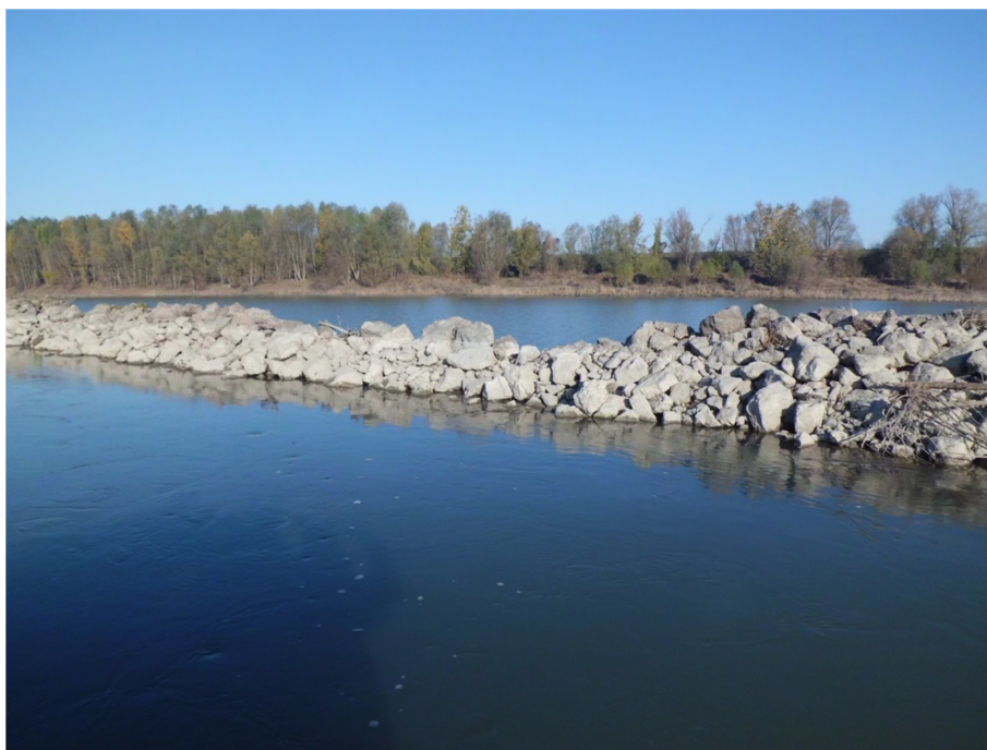
Figura 5. Secondo tratto con sagoma maggiormente ammalorata per una estesa complessiva di circa 50m.
