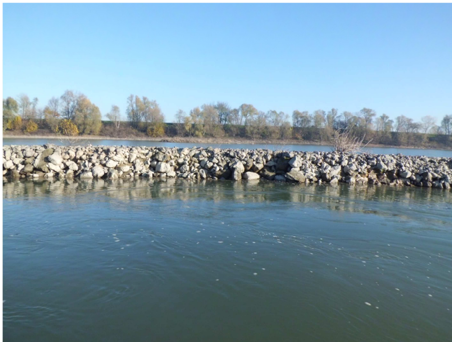
Figura 2. Scoscendimenti di pietrame lungo la scarpata lato fiume sul pennello di Stienta
