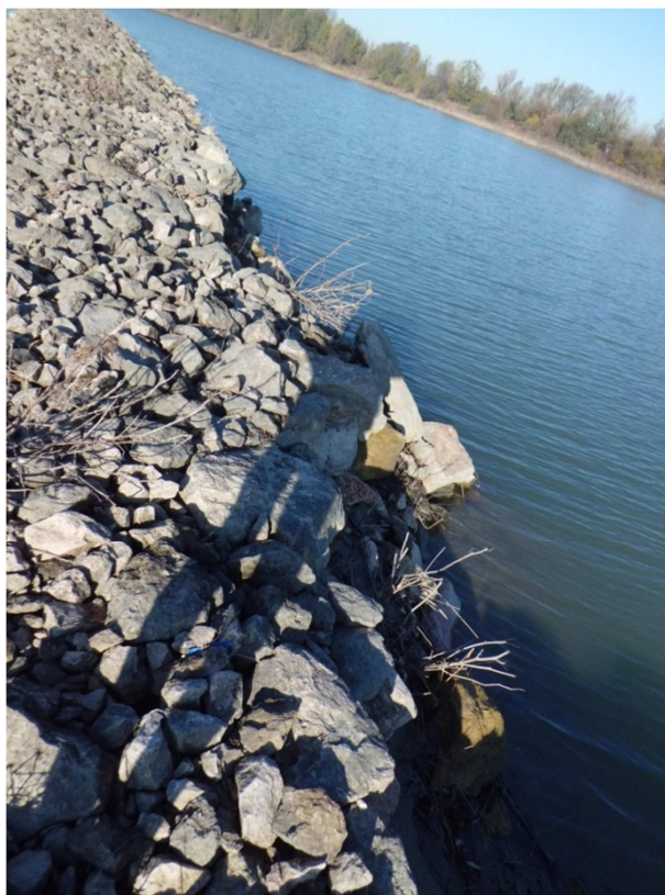
Figura 4. Primo tratto ammalorato con leggero franamento della scarpata in pietrame, lato argine sx di Po, per una estesa di circa 30 m
