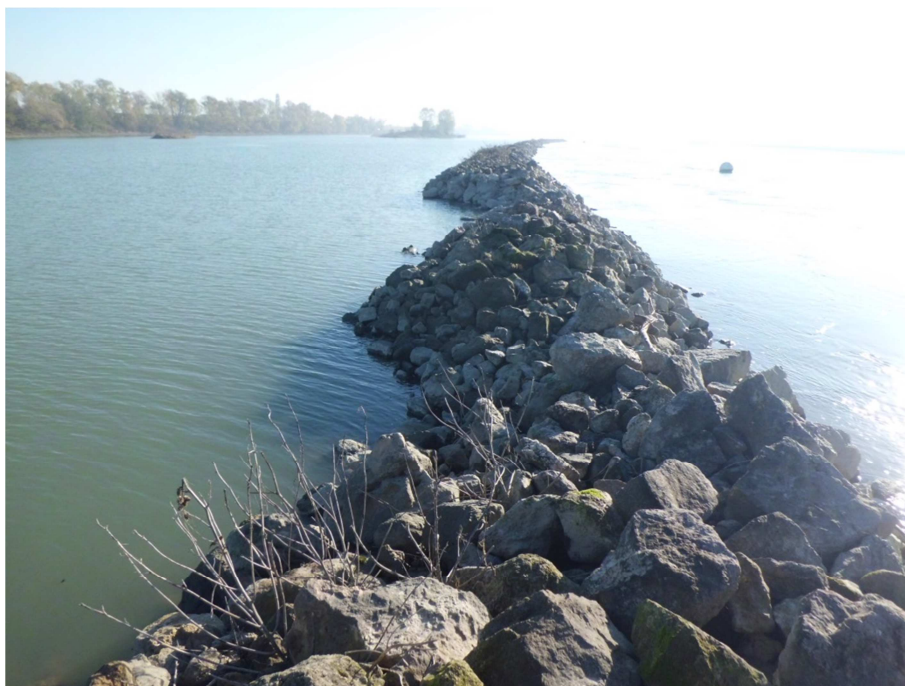
Figura 6. Secondo tratto con sagoma maggiormente ammalorata per una estesa complessiva di circa 50m.
