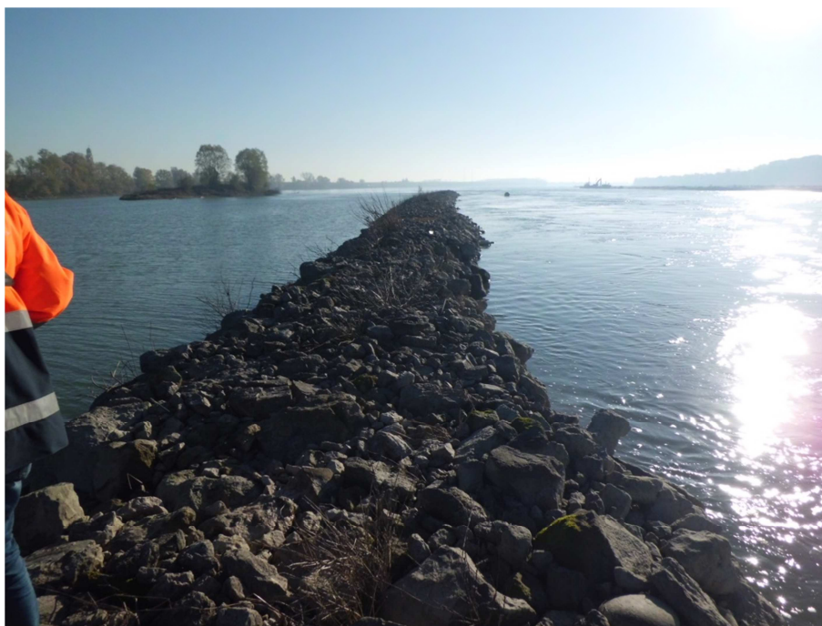
Figura 3. Scoscendimenti di pietrame lungo la scarpata lato fiume sul pennello di Stienta
