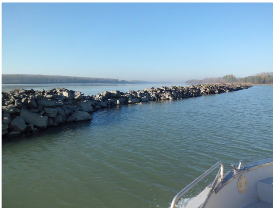
Figura 7. Secondo tratto con sagoma maggiormente ammalorata per una estesa complessiva di circa 50m.
