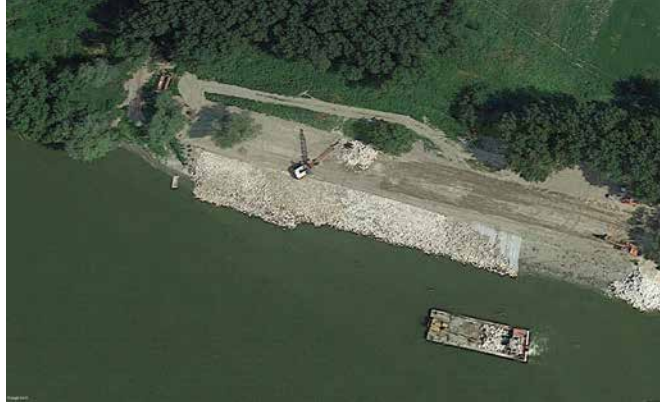
Vista aerea dell'area di cantiere durante l'esecuzione dei lavori
