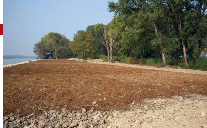
Copertura dell'area di cantiere con fieno autoctono
