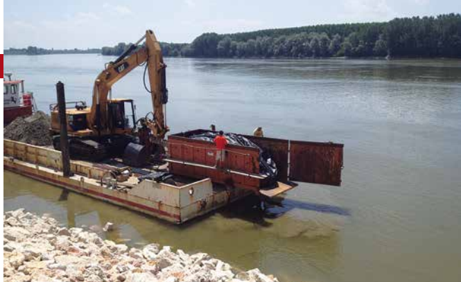
Varo di saccone in sabbia a costituzione del nucleo del pennello
