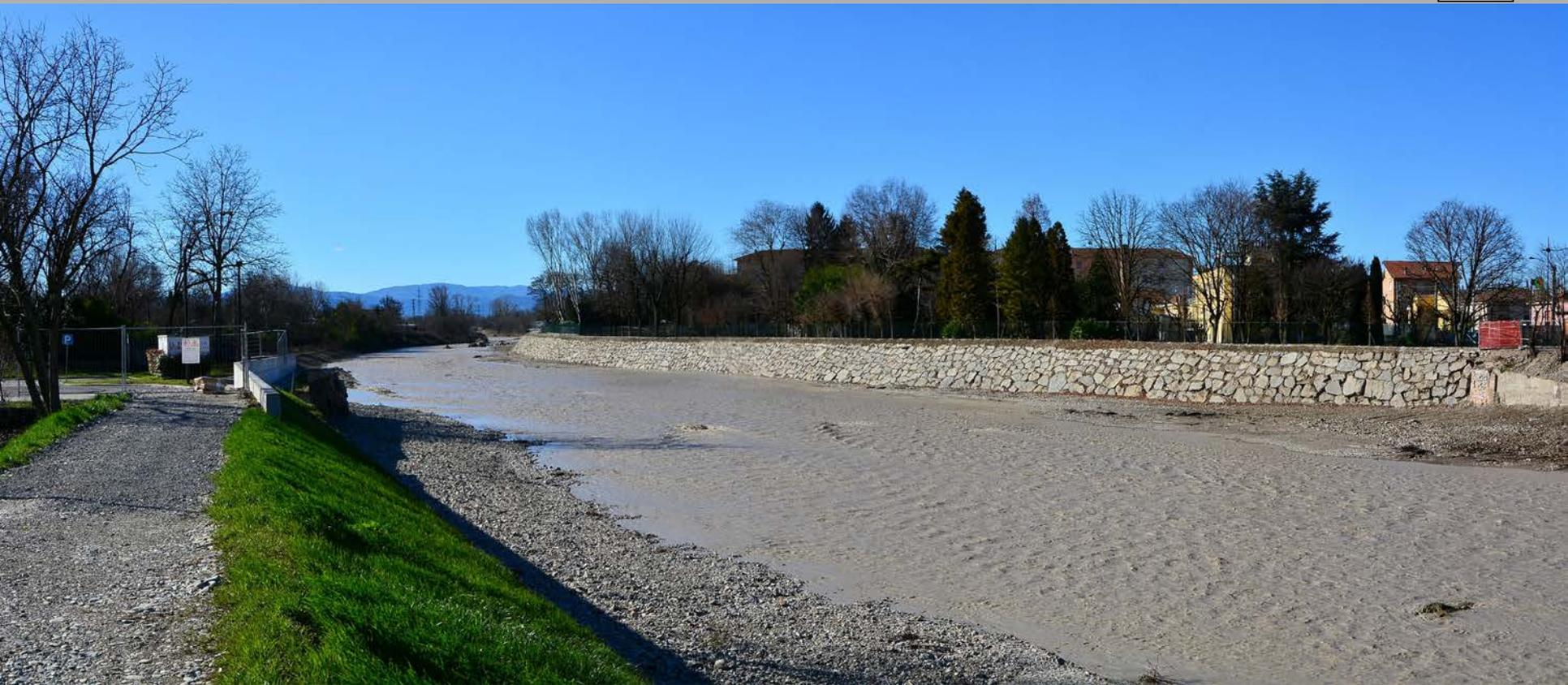
**Immagine, presa da valle verso monte, del nuovo argine carrabile, protetto da una scogliera in massi arenacei, posto in sinistra idraulica del Torrente Baganza a protezione del Quartiere Molinetto, tra via Taro a nord e via Campanella a sud.**
