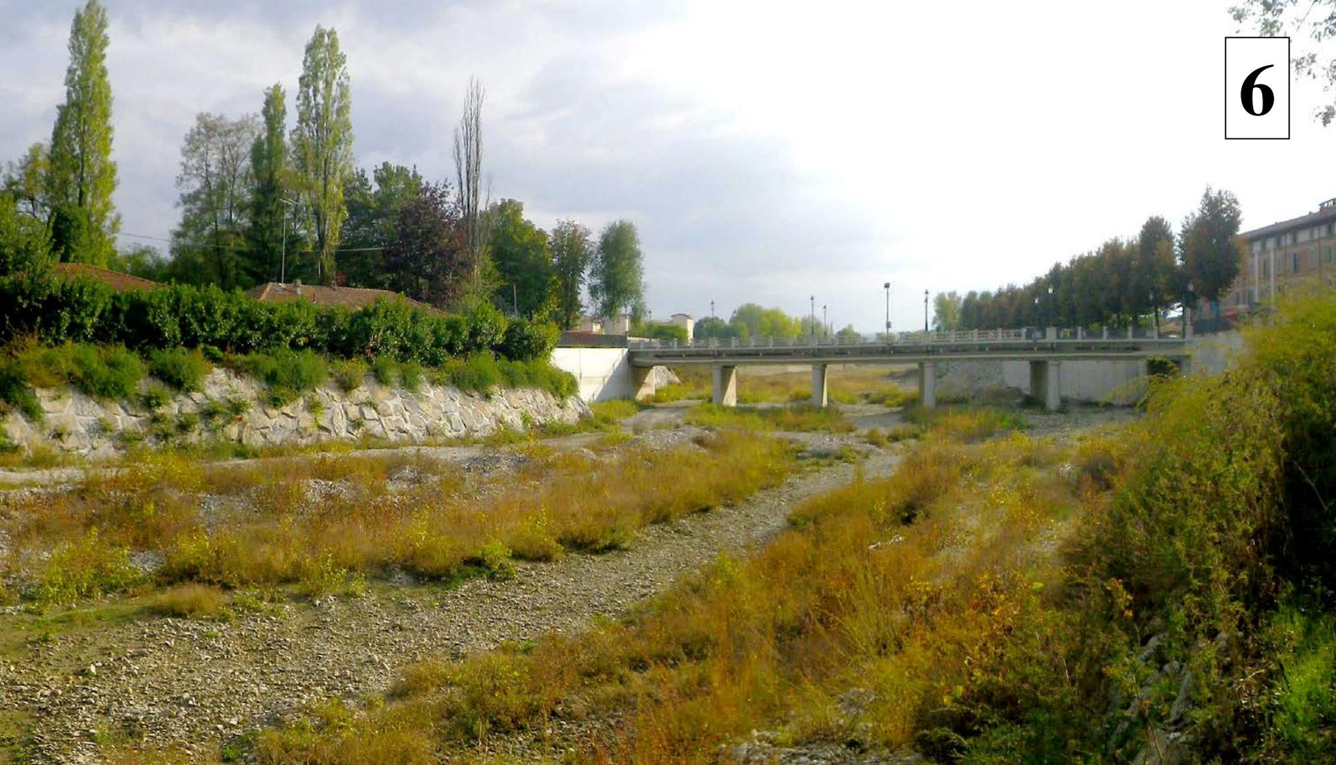
**Torrente Baganza a valle del Ponte Nuovo. In evidenza i nuovi muri andatori in calcestruzzo armato e le difese in massi, eretti, sia in destra che in sinistra idraulica, al fine di massimizzare la sezione di deflusso idrico. SITUAZIONE A OTTOBRE 2016**
