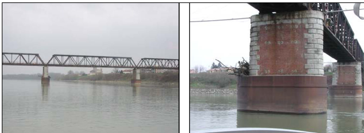
Figura 32 – Ponte linea ferroviaria Parma - Brescia
