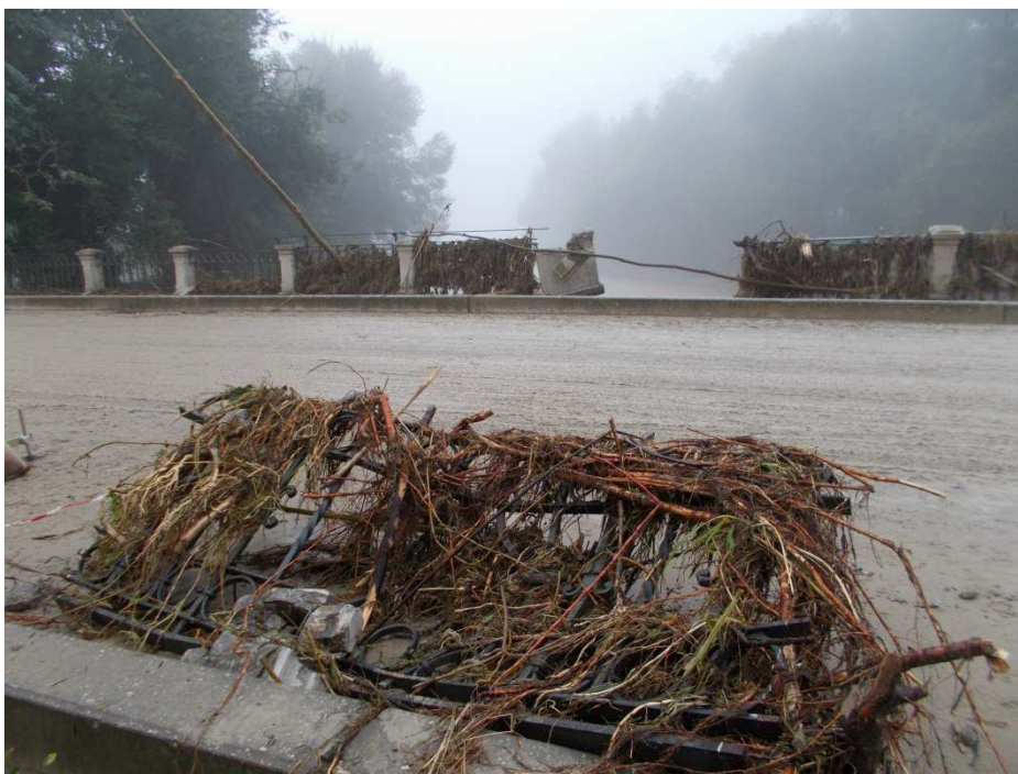
Figura 2-6 – Piena del torrente Baganza del 13/10/2014 a Ponte Nuovo, già ponte dei Carrettieri, con evidenti segni di sormonto (foto Marco Belicchi, 14/10/2014 ore 8.44).
