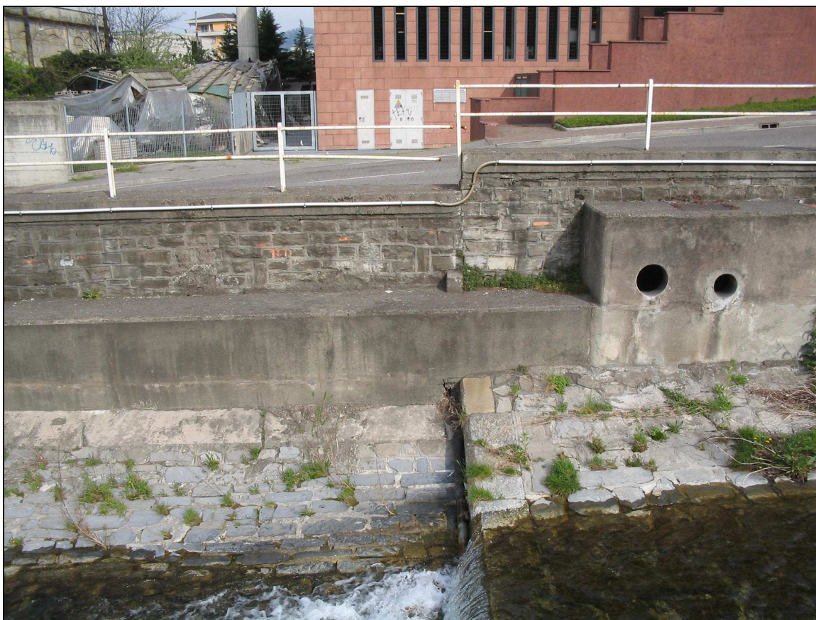
Figura 6– Muro di sponda da riportare in quota a garanzia del franco idraulico(Sez. n. 45)
