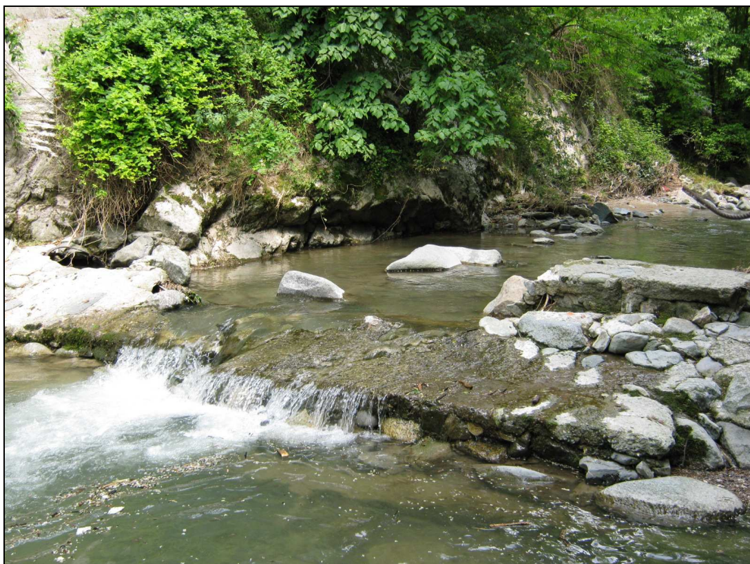
Figura 3– Briglia in calcestruzzo danneggiata da ripristinare
