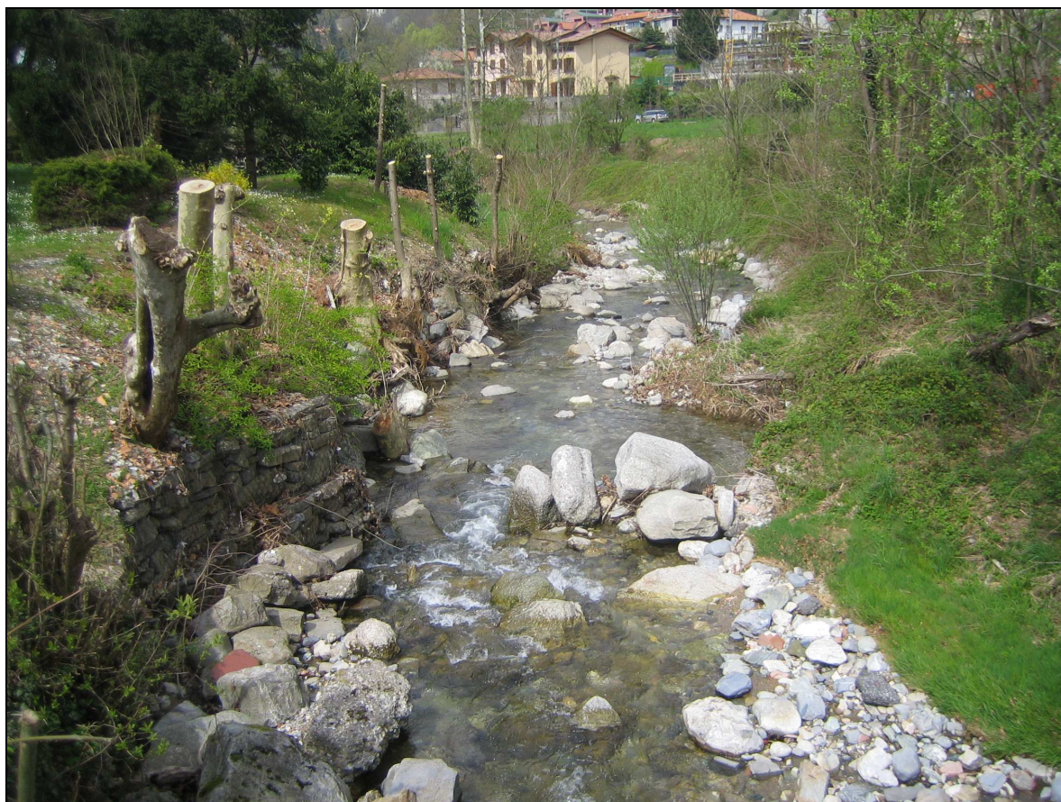
Figura 7– Gabbioni in sinistra che verranno demoliti e sostituiti da difesa spondale
