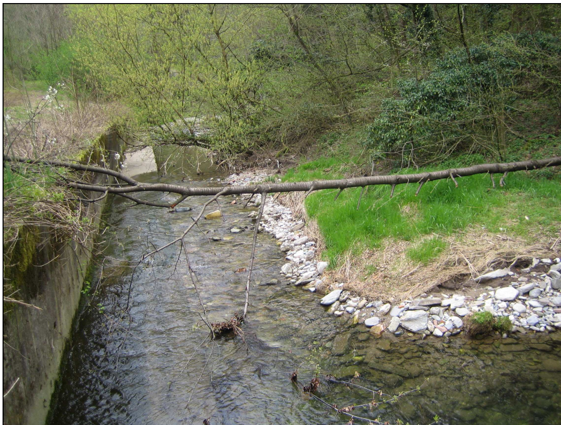
Figura 8– Muro gravemente eroso al piede visto da valle
