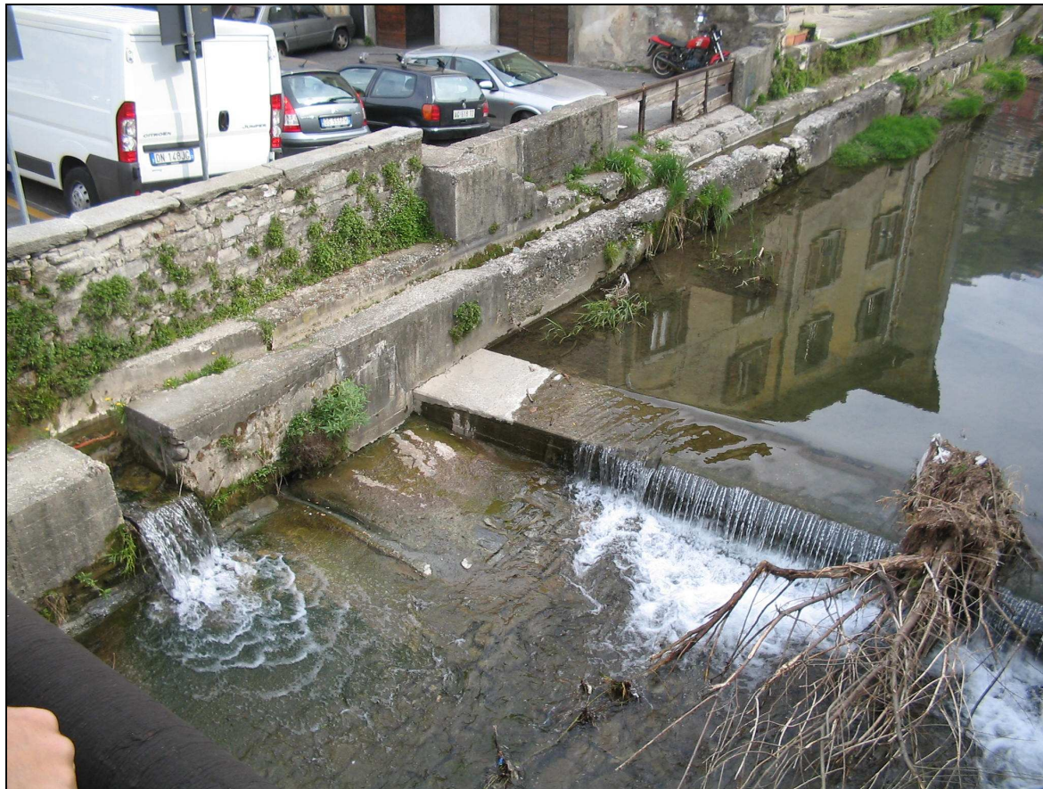
Figura 5– Muro di sponda destra da riportare in quota a garanzia del franco idraulico(a monte sez. n. 42)
