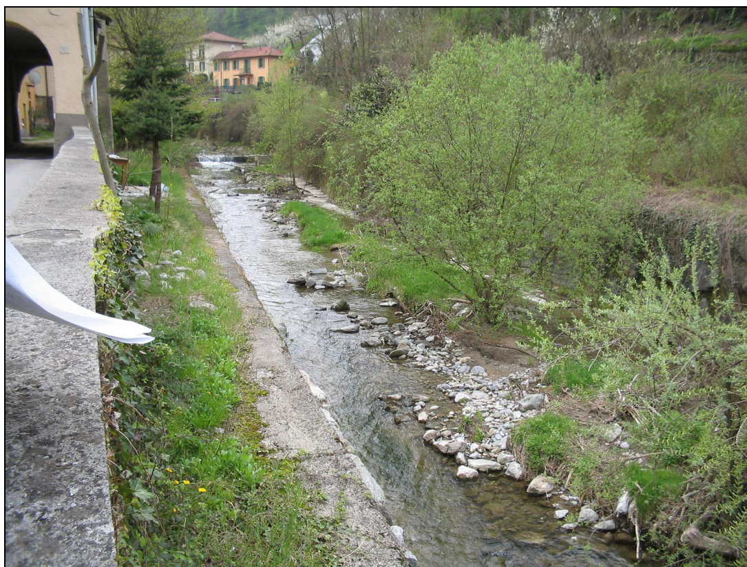
Figura 9– Materiale da movimentare al fine di garantire una migliore officiosità dell'alveo
