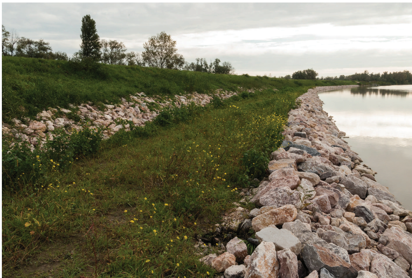
Esempio di difesa di sponda in pietrame naturale nella fase di completamento dei lavori.
