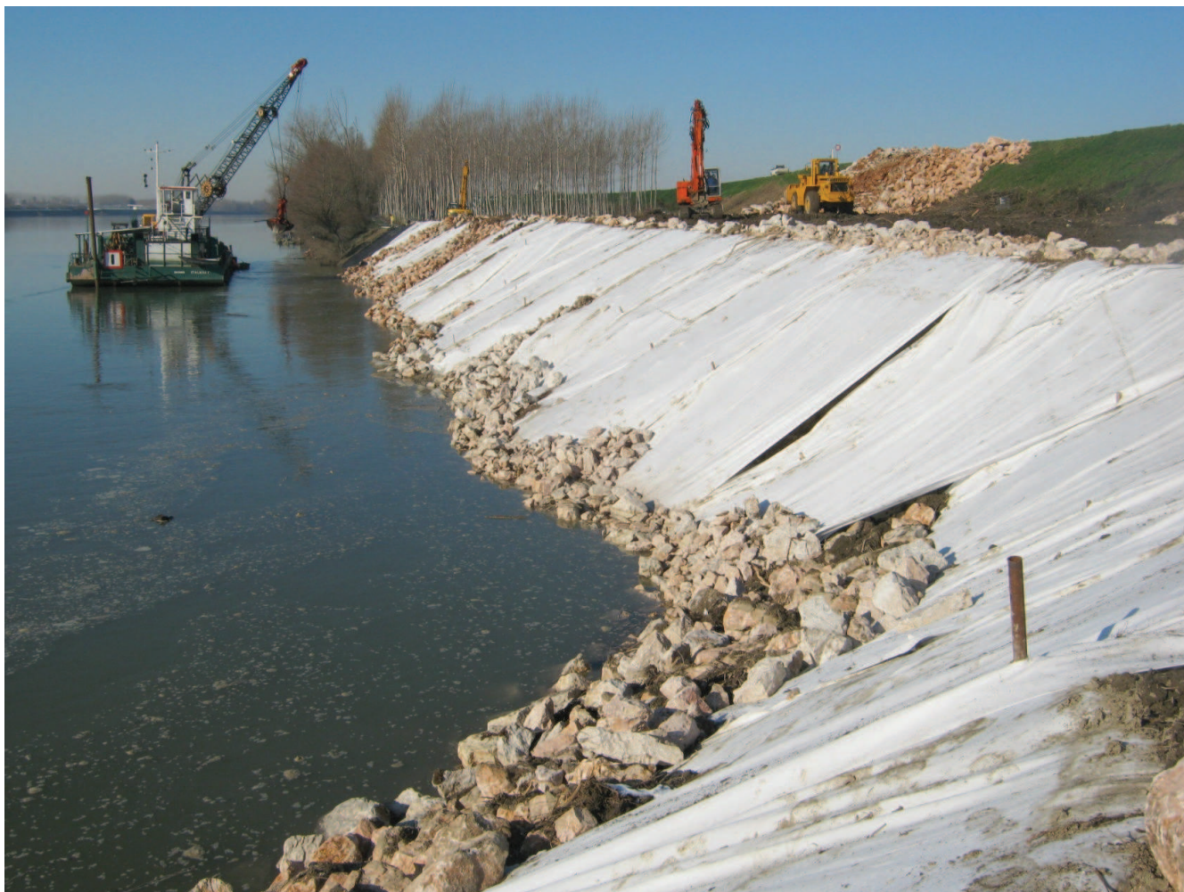
Difesa spondale sx Po – Calto - posa di pietrame di piccola pezzatura a protezione del geotessuto (parte superiore della scarpata).
