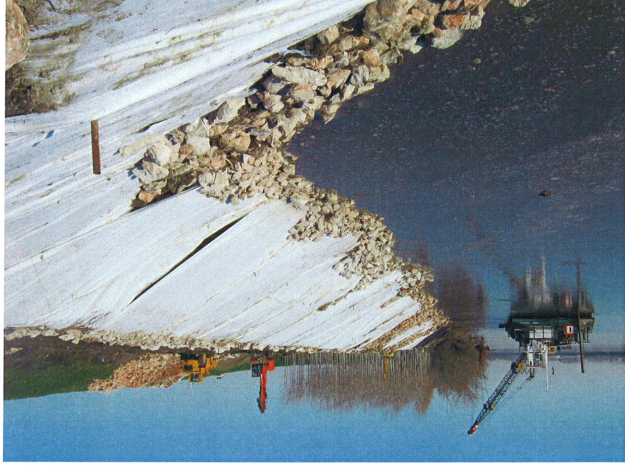
Difesa spondale sx Po – Catto – posa di pietraime di piccola pezzatura a protezione del geotessuto (parte superiore della scarpata).
