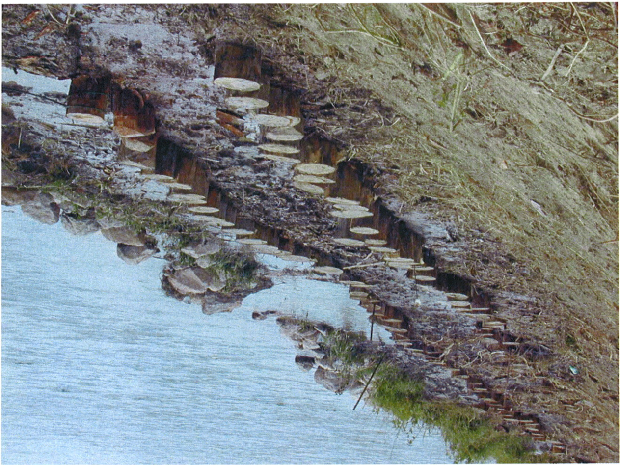
Esempio di difesa di sponda in pietra naturale nella fase di completamento dei lavori.
