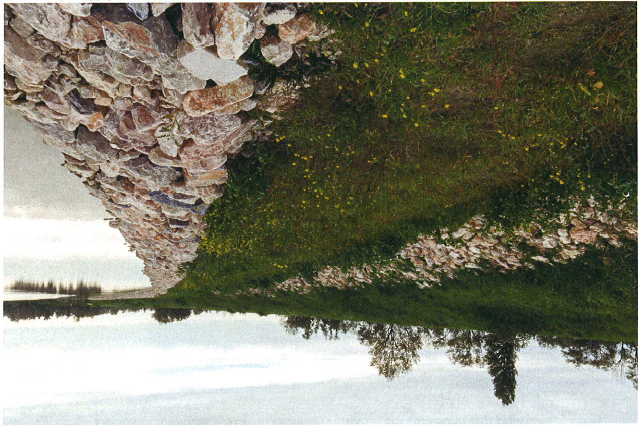
Esempio di difesa di sponda in pietra naturale nella fase di completamento dei lavori.
