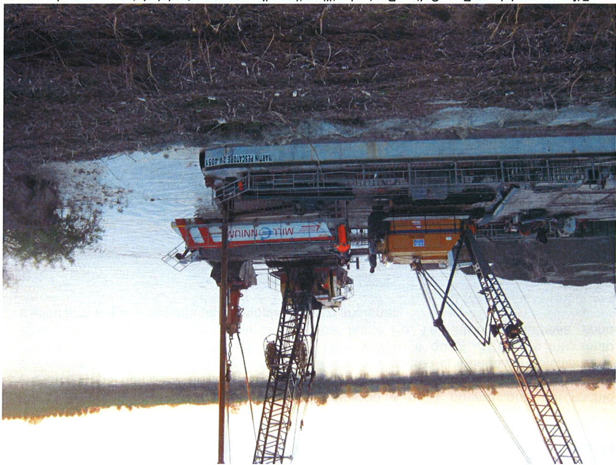
Difesa spondale sx Po – Calto - Pontoni utilizzati per l'annegamento del pietrame e per la formazione e varo dei sacchi di sabbia da 25 mc a formazione della berma sommersa.
