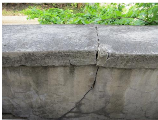
VISTA DI UNA CREPA LUNGO LA COPERTINA E LA PARTE INTONACATA DEL MURO
