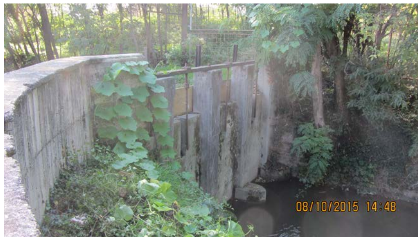
Figura 14 - Vista del manufatto di regolazione sulla Roggia Lupa dal lato interno dal quale si nota l'assenza delle paratoie
