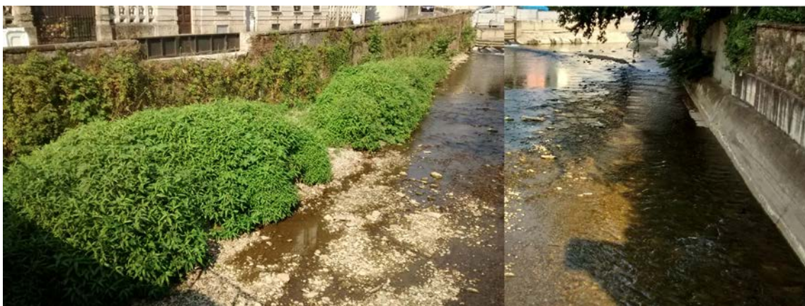
Figura 20 – Vista dal ponte di via Annoni dell'alveo del Lambretto, sulla sinistra il deposito di materiale da rimuovere
