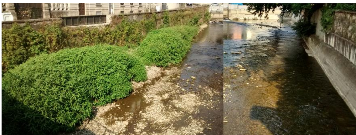
VISTA DAL PONTE DI VIA ANNONI DELL'ALVEO DEL LAMBRETTO, SULLA SINISTRA IL DEPOSITO DI MATERIALE DA RIMUOVERE
