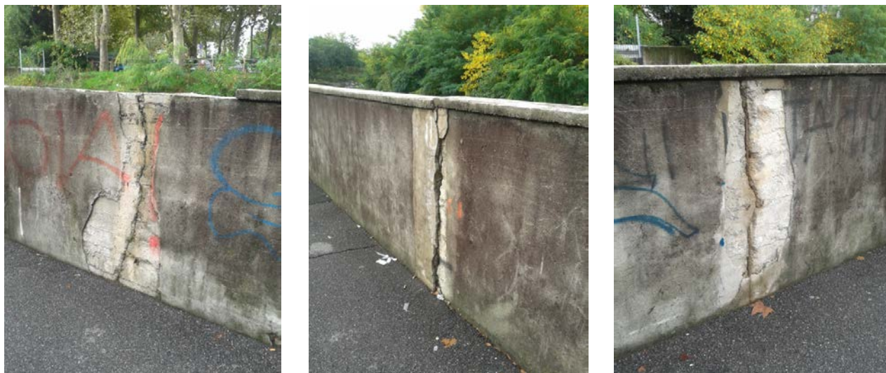
Figura 12 – Vista delle crepe presenti lungo il muro spondale di Via Ghilini
