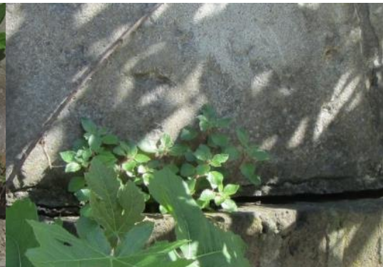
Figura 10b – Particolare della fessura presente alla base del rialzo del muro spondale
