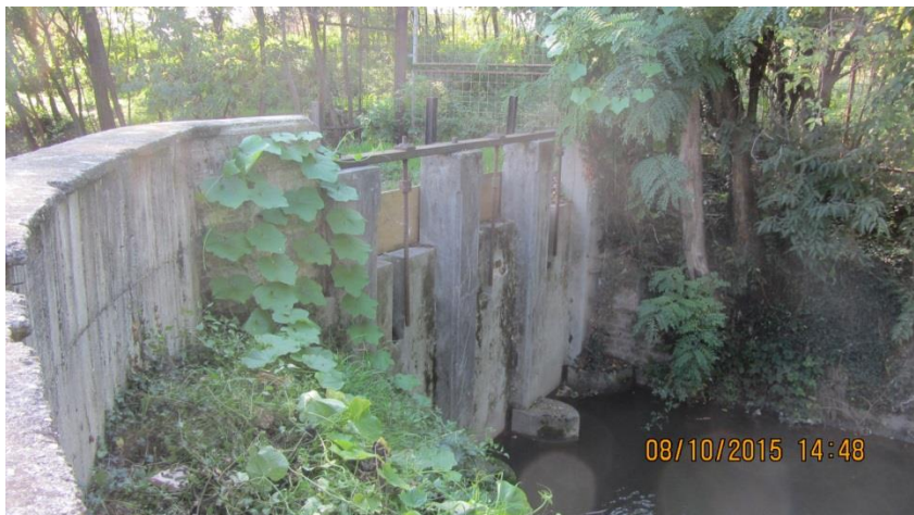
VISTA DEL MANUFATTO DI REGOLAZIONE SULLA ROGGIA LUPA DAL LATO INTERNO DAL QUALE SI NOTA L'ASSENZA DELLE PARATOIE
