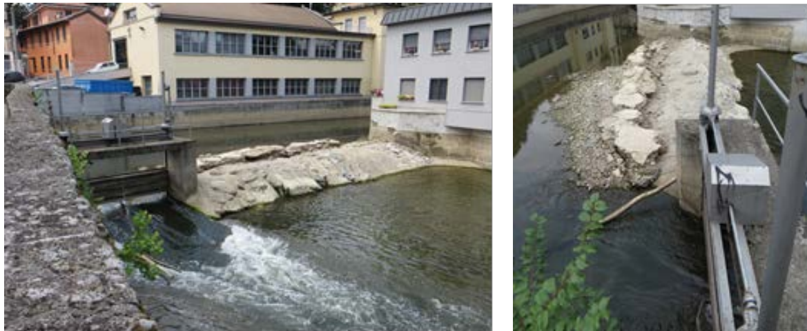
Figura 19 – Vista frontale (a sinistra) e laterale (a destra) della traversa di derivazione del Lambretto
