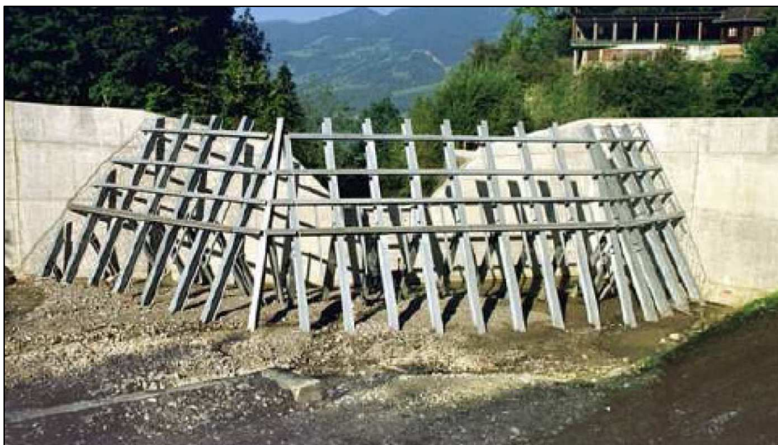
Figura 19 - Esempio di briglia selettiva con configurazione tipo C
