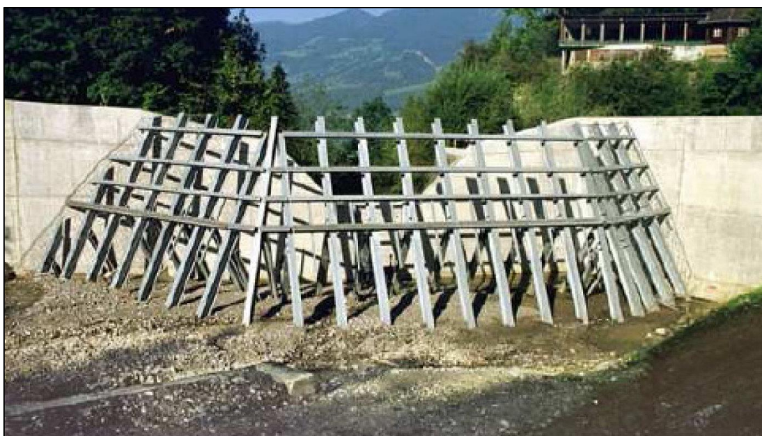
Figura 9 - Esempio di briglia selettiva con configurazione tipo C
