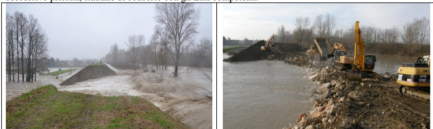
Fig. 1 e 2 Rotta dell'argine destro del Fiume Secchia in loc. S. Matteo e sua riparazione - 19 e 21 genn. 2014
