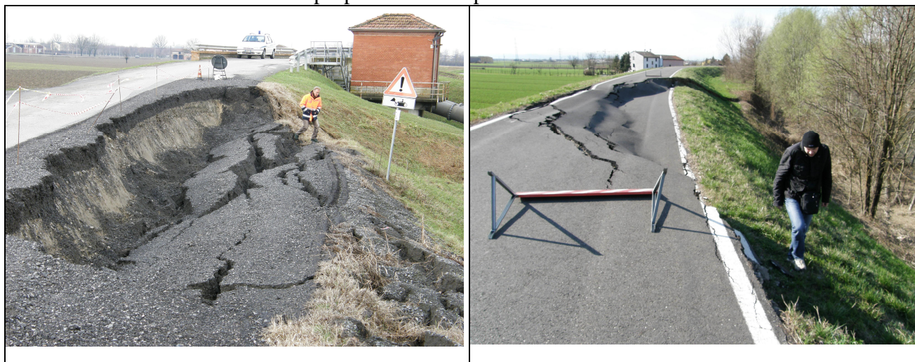
Figg. 28 - 29 esempi di sfiancamento arginale: F. Po a Polesine P.se. e T. Parma a Copermio (PR)
