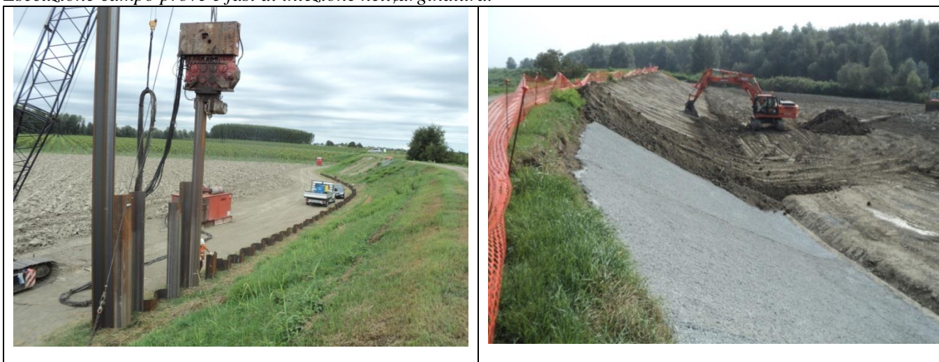
Figg. 12 - 13 cantiere di diaframmatura con palancole in acciaio, cordolo e rivestimento in calcestruzzo armato ó loc. Cavezzo Via Bozzala.
