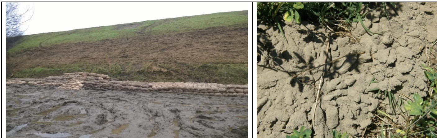
Figg. 37 - 38 Fenomeni di filtrazione/sfiancamento iniziale dell'argine e manifestazioni di liquefazione sismica delle sabbie a Cavezzo via Bozzala (rispettivamente febbraio e luglio 2014)
