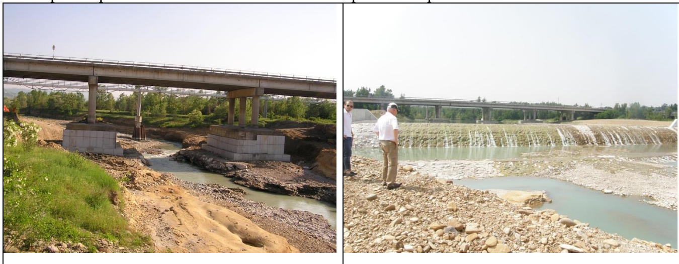
Fig 5 - Fiume Secchia attraversamento in viadotto della SS. n. 467 di Scandiano: profonda erosione con scalzamento delle pile a seguito del crollo della traversa in loc. Villalunga di Sassuolo (maggio 2004)
