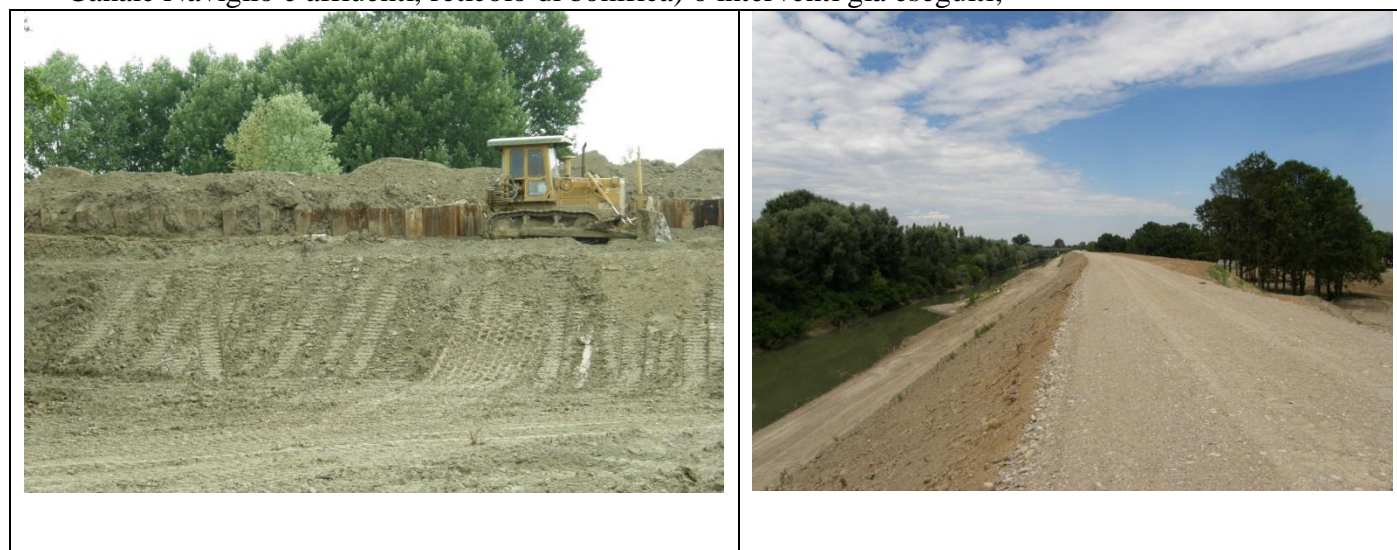
Figg. 8 - 9 ó Lavori di ripresa della rotta ó palancolata e realizzazione della banca a campagna; lavori ultimati.
