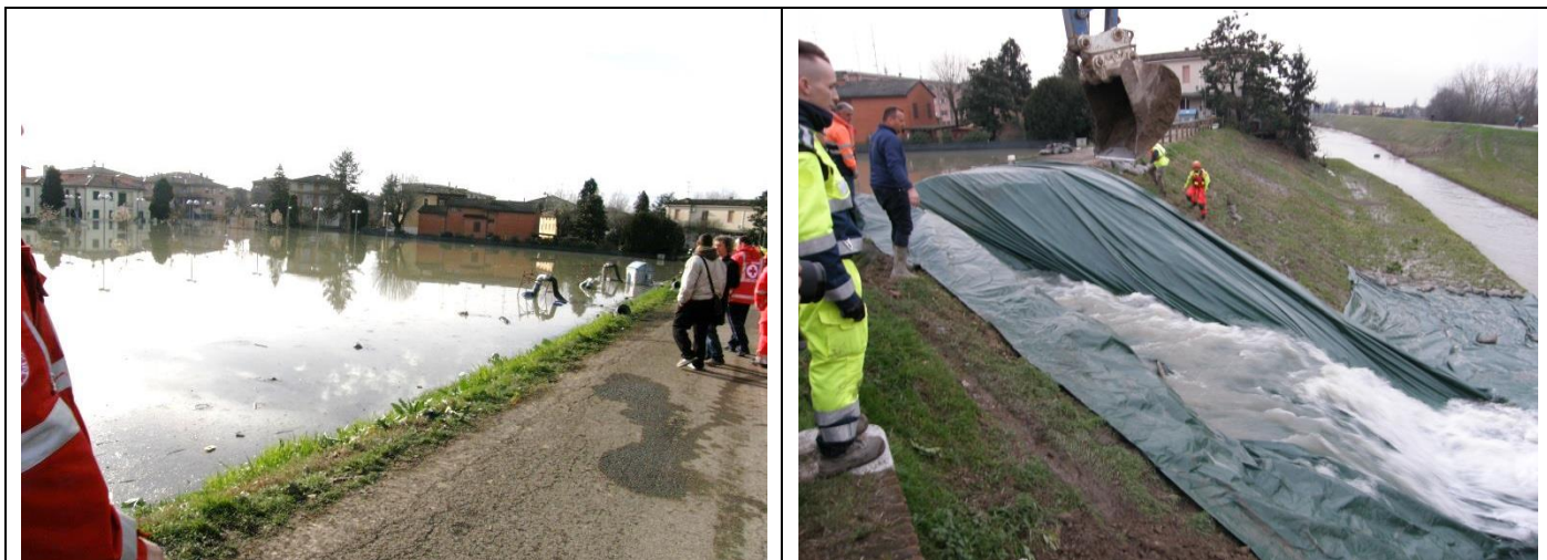
Fig. 3 Effetti a valle: inondazione del centro abitato di Bomporto e svuotamento tramite taglio controllato dell'argine del Canale Naviglio - 23 gen. 2014.
