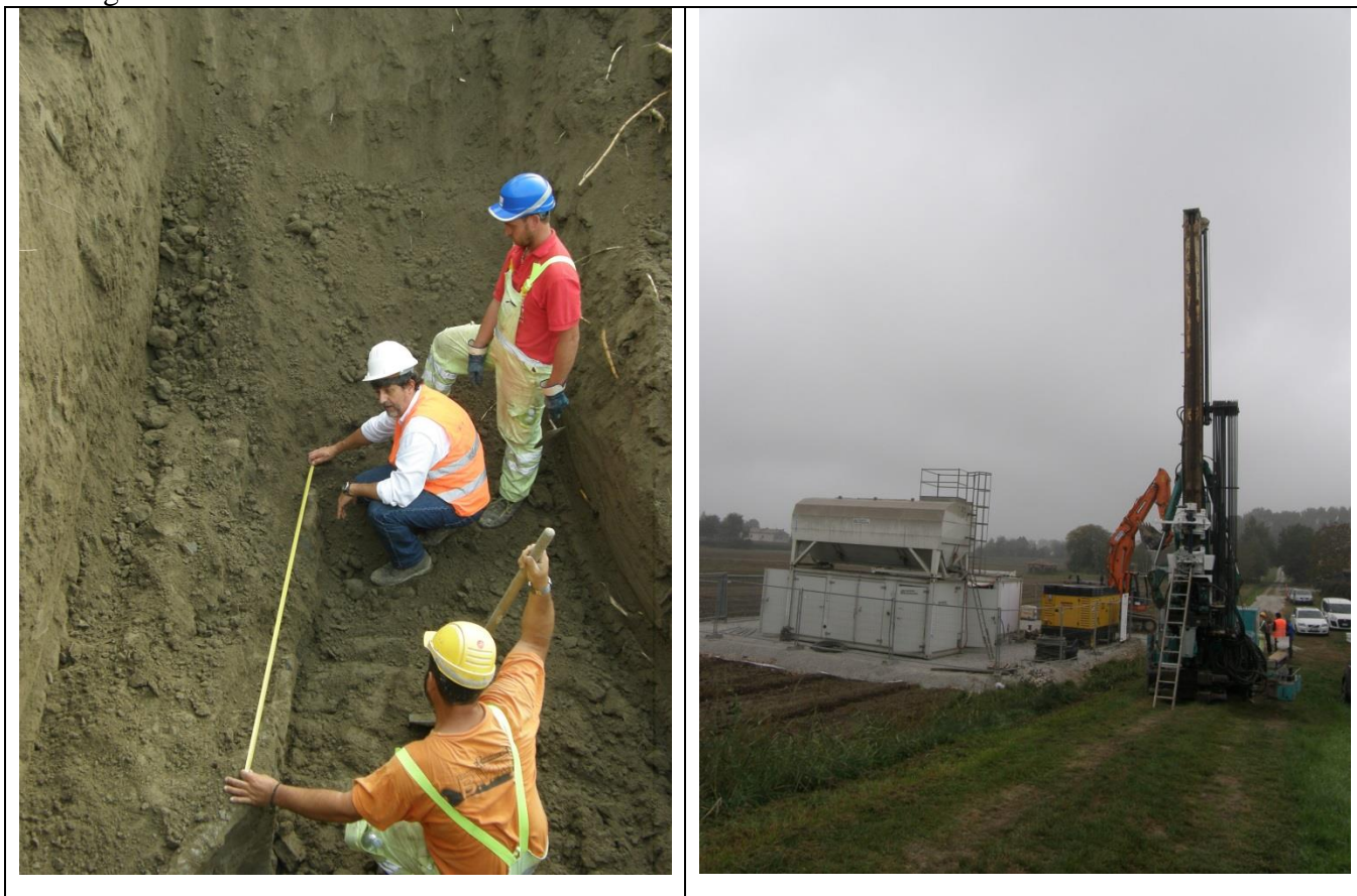
Figg. 10 - 11 cantiere di diaframmatura con jet grouting monodirezionale in loc. Ponte Pioppa - Esecuzione campo prove e fasi di iniezione nell'arginatura.
