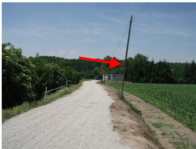
Figura 3-1 Palo della linea telefonica interferente e da spostare (sponda destra – Via Aulina)
