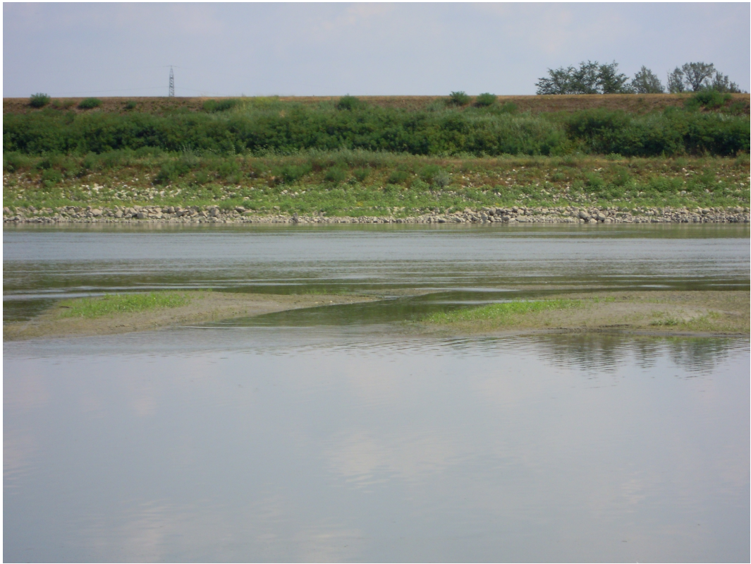
Figura 17. Arginatura in frodo in comune di Stienta interessata da profonde erosioni causate dai depositi fluviali, bassi fondali antistanti.
