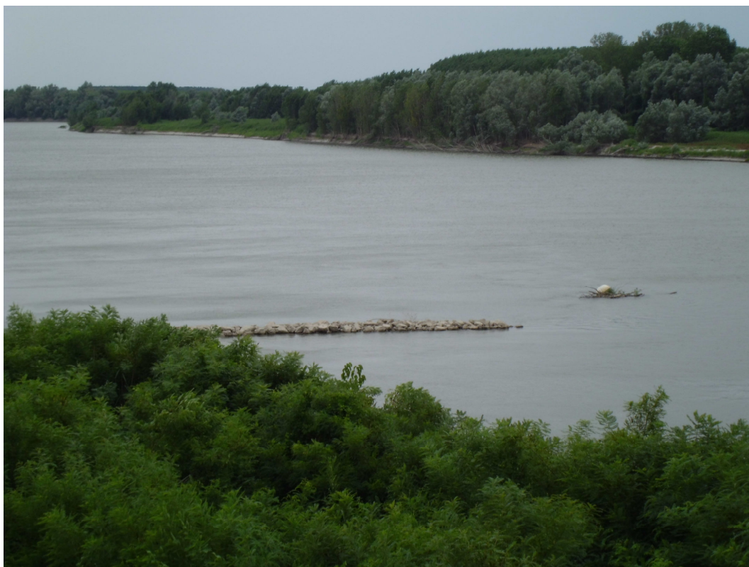
Figura 2. Castelmassa, pennelli esistenti in sinistra idraulica oggetto di completamento.
