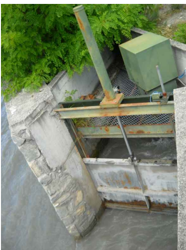
Intervento A3: adeguamento chiavica esistente su scarico centrale ICOM (CH1)
