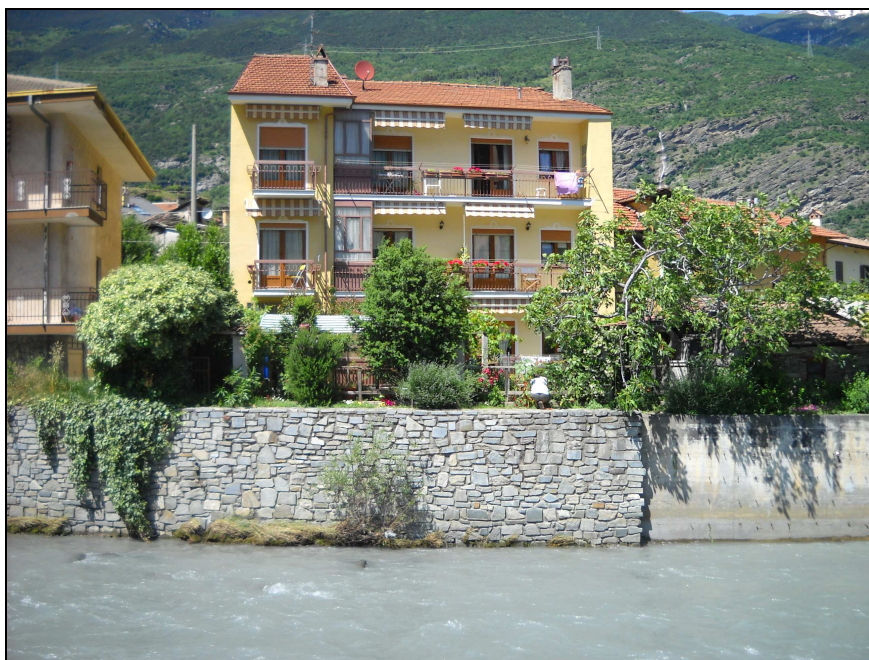
Figura 14: Muro di difesa in sponda sinistra, in parte già rivestito con pietra locale.
