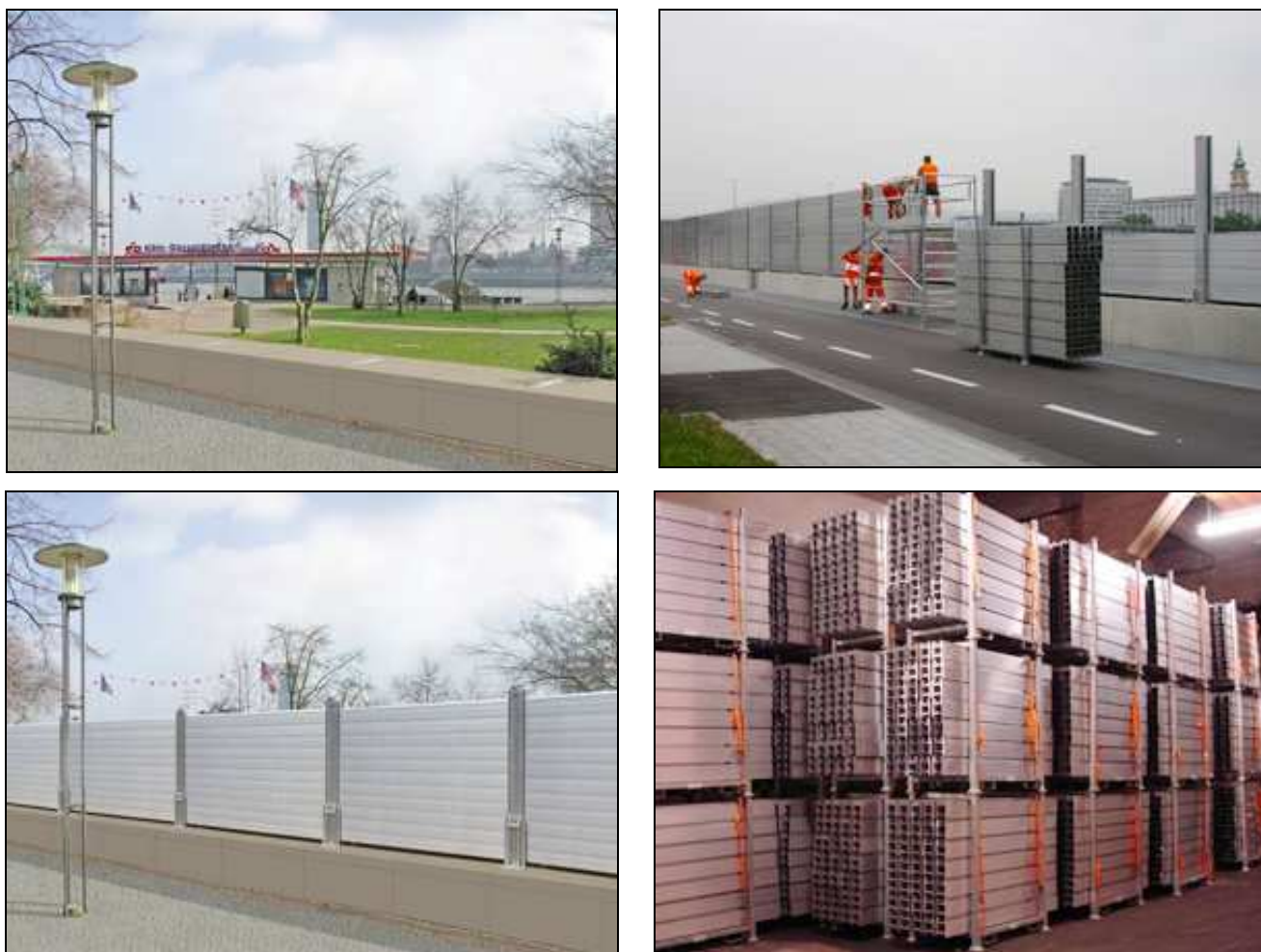
Figura 11: Schema funzionale dell'utilizzo di sovralti temporanei modulari in alluminio con montanti rimovibili ; nell'immagine in alto a sinistra è rappresentata la condizione ordinaria in cui vi è solo il parapetto in muratura con predisposizione alloggiamenti per barriera temporanea, nell'immagine in alto a destra l'installazione di montanti e panconi in previsione di evento straordinario, in basso a sinistra la barriera temporanea completamente montata ed in basso a destra i moduli di trasporto ed immagazzinamento dei sovralti modulari nei periodi di non utilizzo (vedi Tavola DRS 3018).
