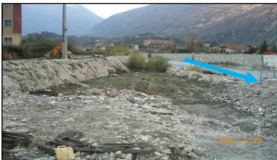
Intervento A – accesso in alveo Dora Riparia tramite rampa in sponda dx in corrispondenza del ponte Briançon
