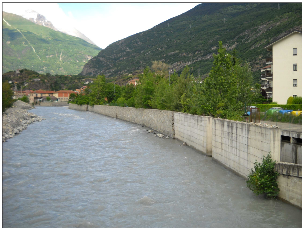
Figura 3: Tratto della difesa di sponda sinistra oggetto di intervento, in parte già rivestita di pietrame (vista da valle verso monte).
