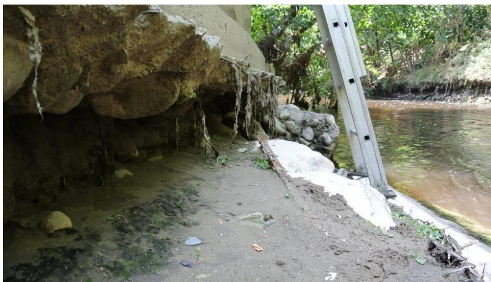
Figura 1.2 - Fiume Lambro a Cologno Monzese, visto verso valle. Terreno di fondazione in sinistra soggetto a fenomeno erosivo.
