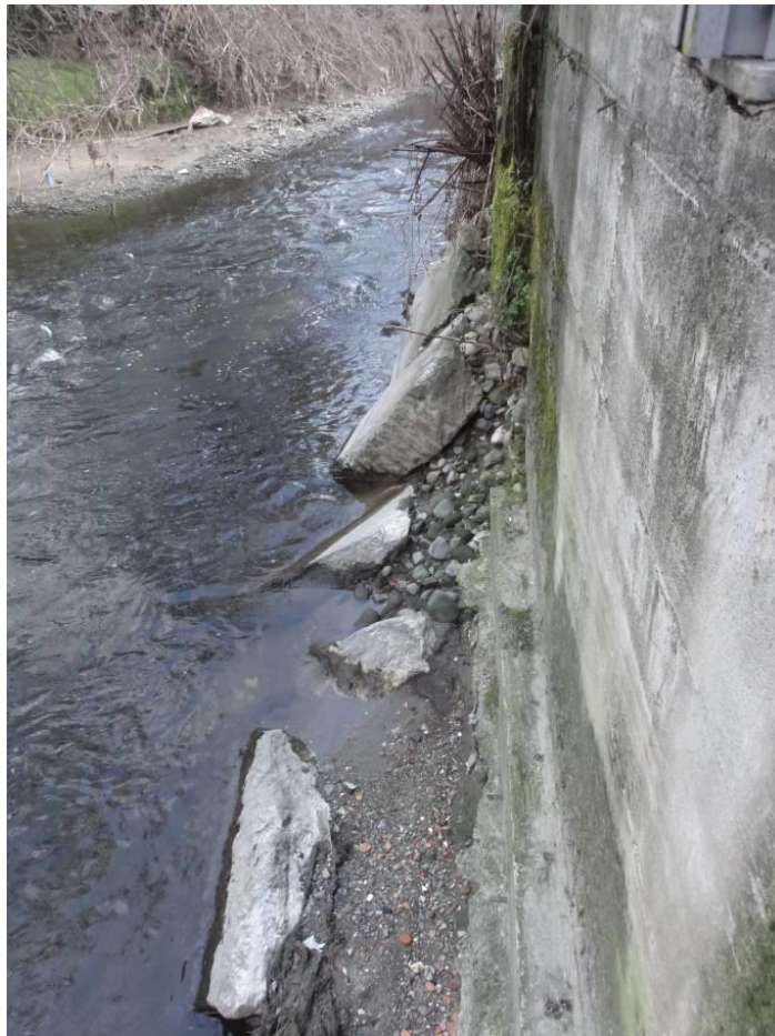
Figura 1.2 – Fiume Lambro a Cologno Monzese, visto verso monte. Pareti verticali in calcestruzzo e fenomeni erosivi al piede delle fondazioni.
