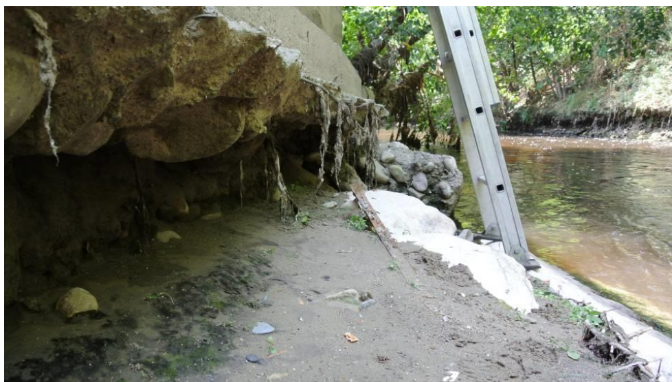
Figura 1.3 - Fiume Lambro a Cologno Monzese, visto verso valle. Terreno di fondazione in sinistra soggetto a fenomeno erosivo.
