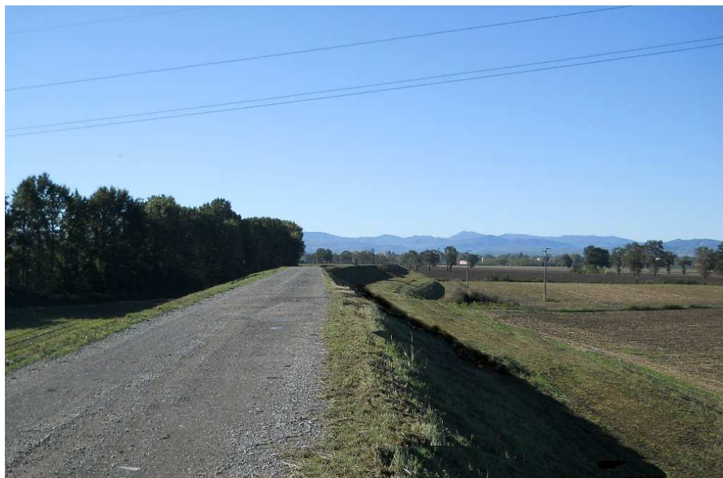
Foto 1B: vista tratto arginale DOPO del rialzo e ringrosso a valle impianto Bonifica
