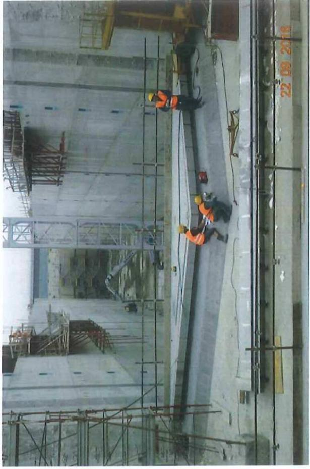
Arrivo in cantiere delle due ante che compongono la porta vinciana di monte ed alloggiamento delle stesse sulle rispettive pilette di appoggio.
