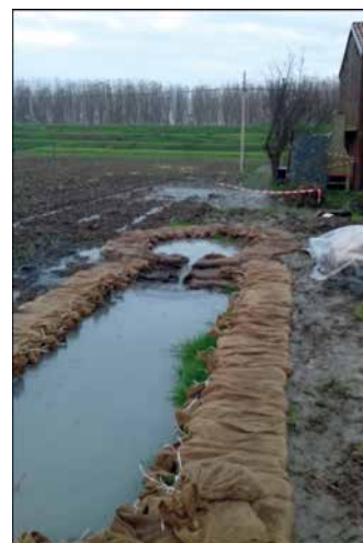
Figura 5 - Località Mazzorno sinistro tra stanti 515-516 (Casa Roncon) – Novembre 2019 - coronella di sacchi impostata a livello del piano campagna nelle vicinanze di un edificio di civile abitazione
