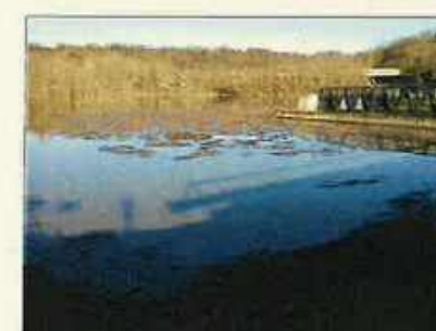
DIGA Ponte Gurone Malnate fiume OLONA
