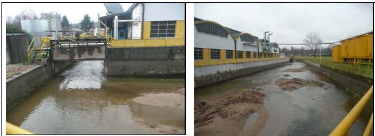
Figura 9. Paratoia di regolazione della corrente fluviale a valle dell'allargamento d'alveo adibito in passato a bacino antincendio (sinistra – sez. 41 visto da monte). Allargamento dell'alveo ad uso bacino antincendio (visto da valle, dx) .
