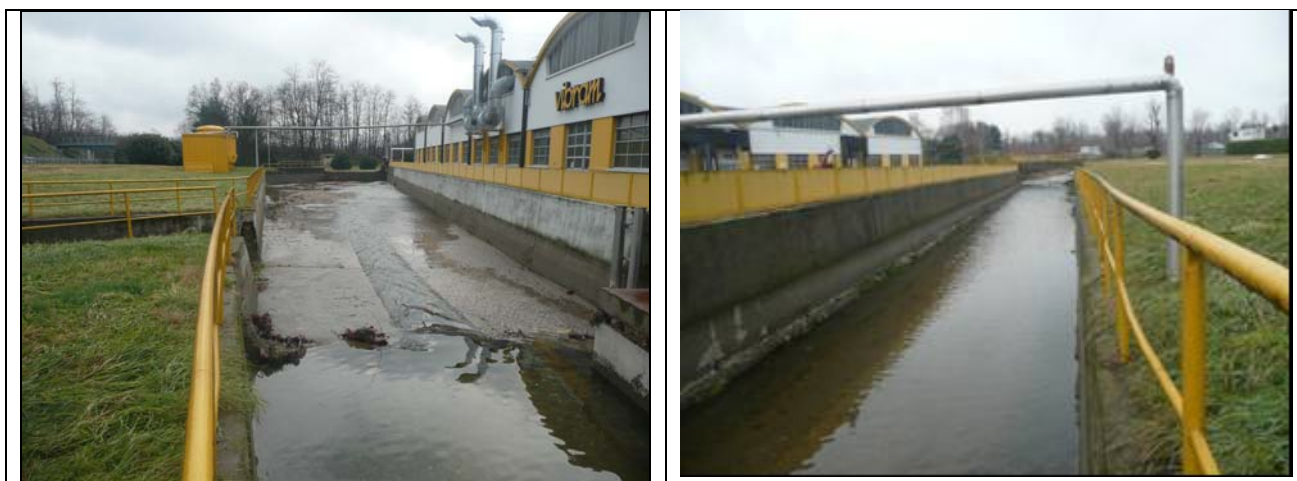
Figura 6. Tratto a monte del bacino di accumulo sul fondo si vede la soglia trapezia da cui la portata di piena sfiora verso i campi a valle in piena (a sinistra) a destra la sezione a monte del bacino di accumulo.
