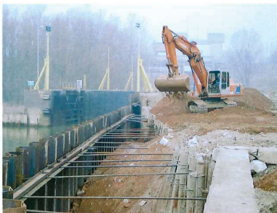
Figura 29: Cedimento palancolato sponda sx preavanconca risalente al 2004
