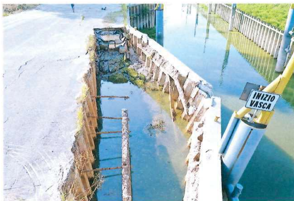
Figura 31: dettaglio cedimento palancolato sponda sx preavanconca risalente al 2022
