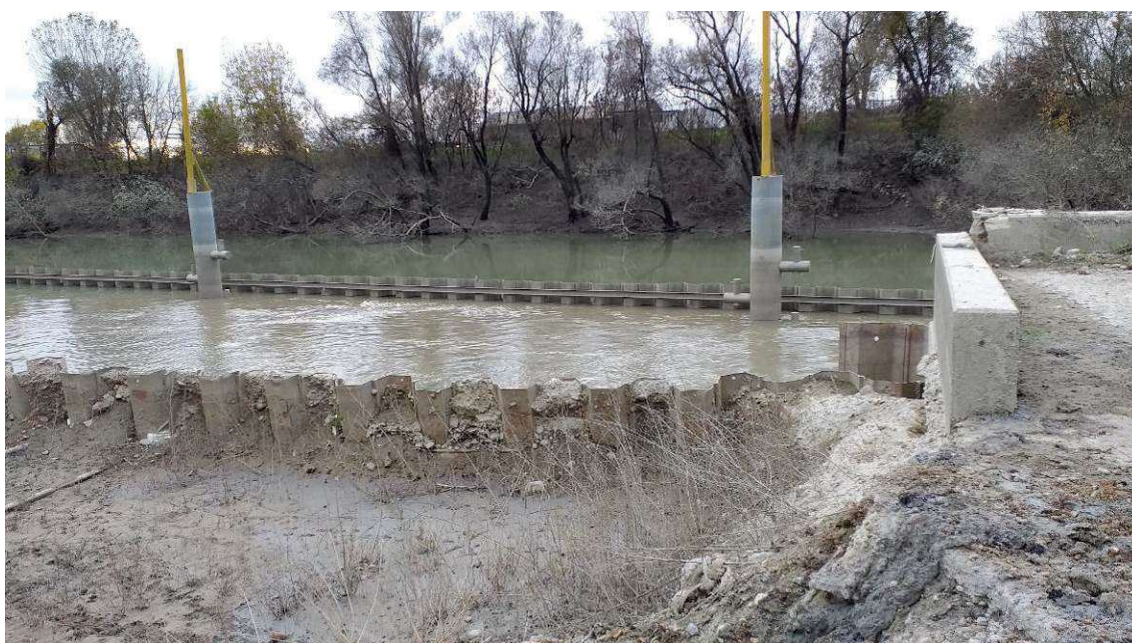
Foto 6: Zona centrale della banchina interessata dal dissesto (nuove palancole di protezione)
