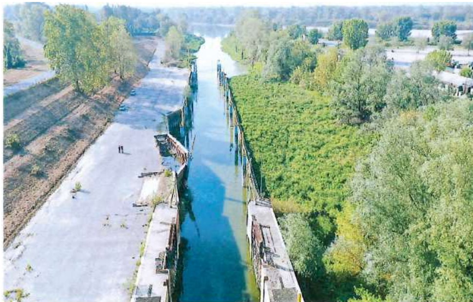
Figura 30: Cedimento palancolato sponda sx preavanconca risalente al 2022
