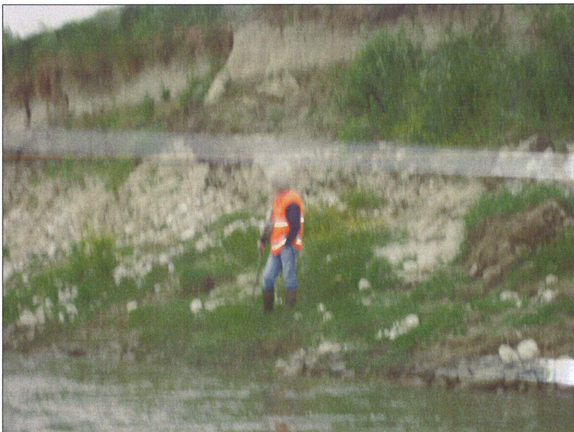
Foto 4 : vista da acqua –dettaglio dell'erosione spondale (tratto di monte con lettura all'idrometro Masero di 50cm inferiore allo zero).
