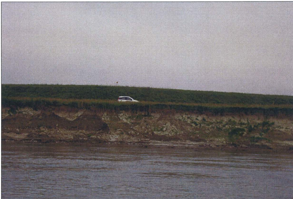
Foto 3 : vista da acqua –dettaglio dell'erosione spondale (tratto di monte).
