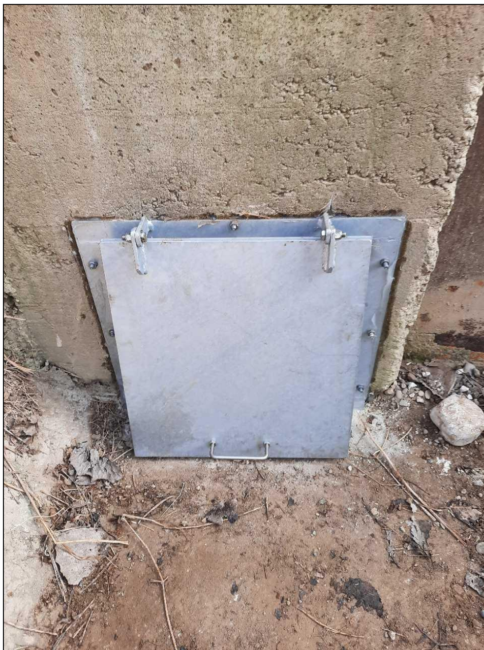
FOTO 4 – sostituzione carpenteria opere di intercettazione idraulica.
