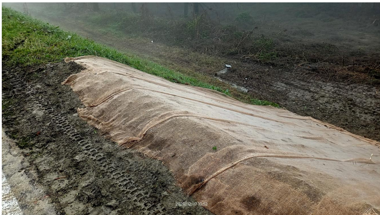
FOTO 9 – ripristino smottamento scarpata argine
