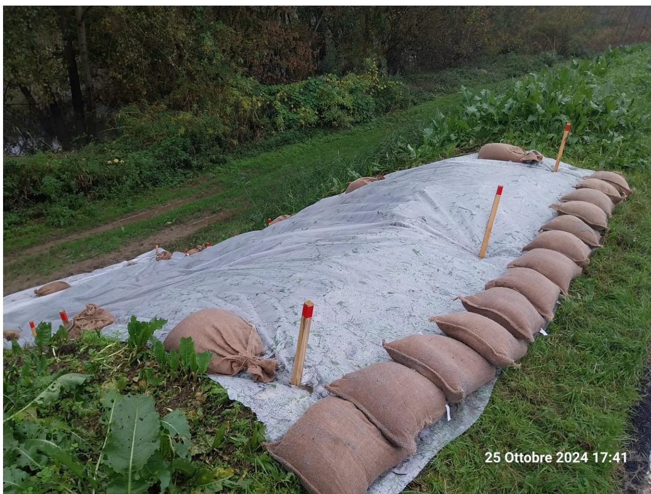
FOTO 8 – primo intervento con telonatura su smottamento arginature
