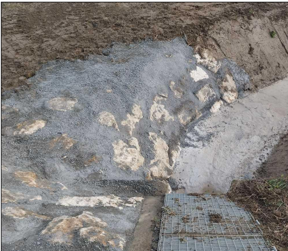
FOTO 5 – sistemazione raccordo imbocco chiavica.
