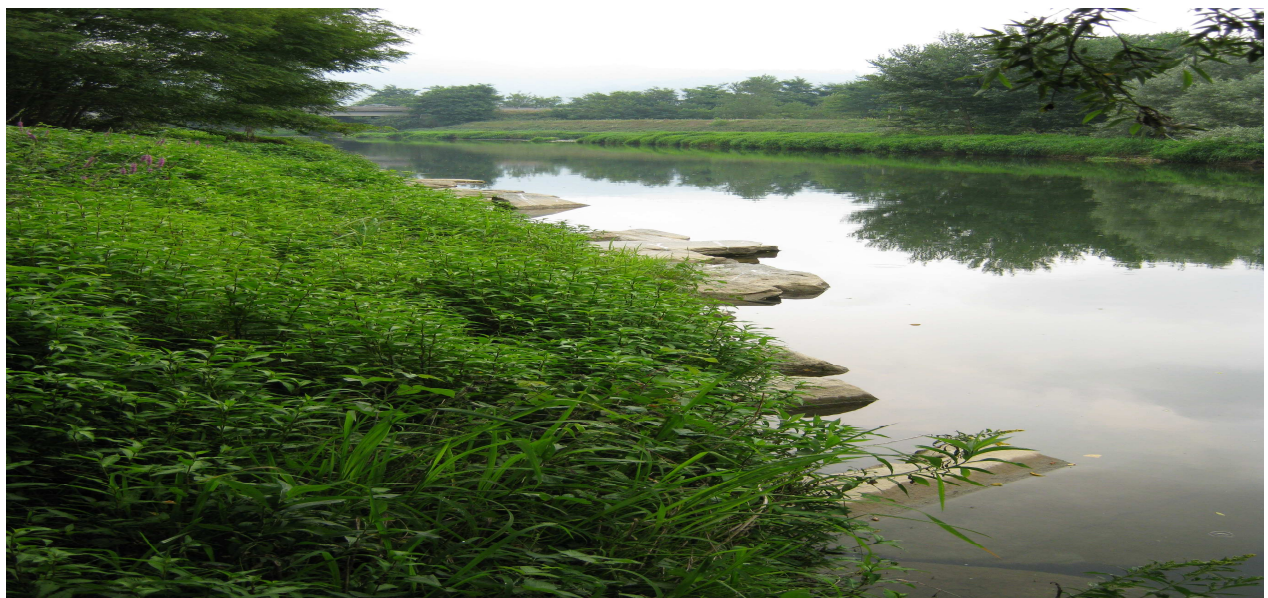
Fig. 12 – Tratto a valle della S.P. 220 : in sponda sinistra sono visibili i massi scalzati della scogliera in corrispondenza dello stabilimento ESSO.
