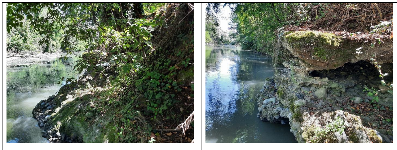
Figura 17 – Difesa sponale ammalorata nei pressi delle sezioni 3 (SX) e 4 (DX).
