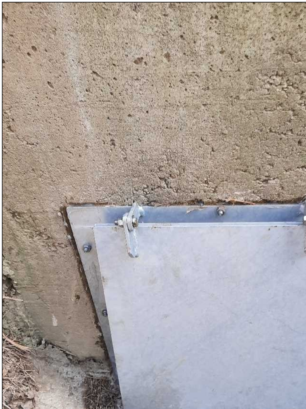
FOTO 4 – sostituzione carpenteria opere di intercettazione idraulica.
