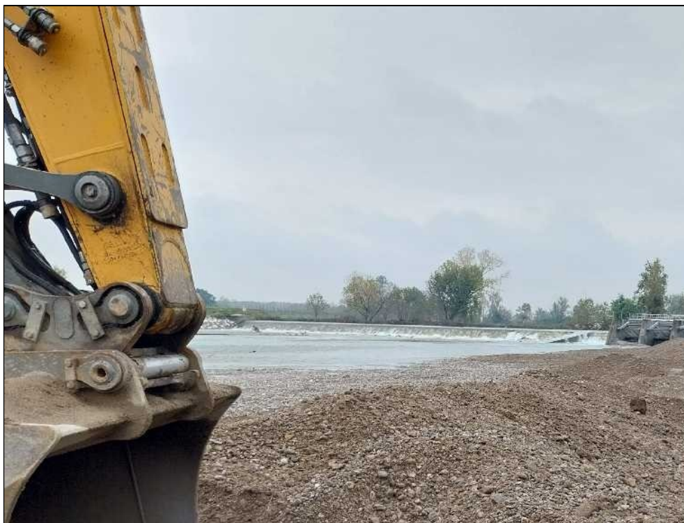
FOTO 6 – movimentazione materiale in alveo per ripristino officiosità idraulica.
