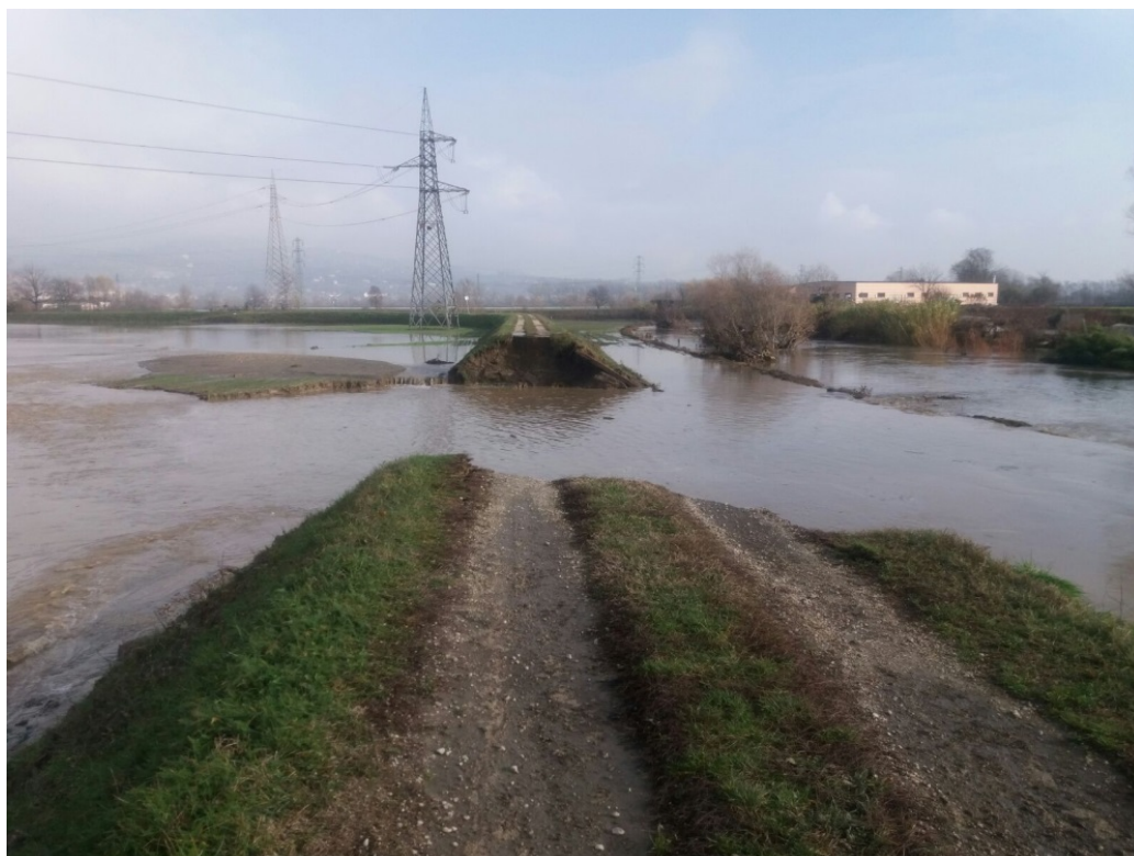
Foto 8 – 26/11/2016: Rotta arginale a valle del ponte di strada Barauda su argine sinistro Vista da monte verso valle
