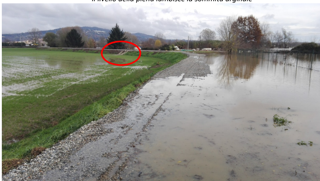
Foto 2 - 25/11/2016 h 11:00: Vista da monte verso valle dell'argine sinistro del T. Chisola, il livello della piena ha raggiunto la sommità arginale ed è iniziata la tracimazione.
