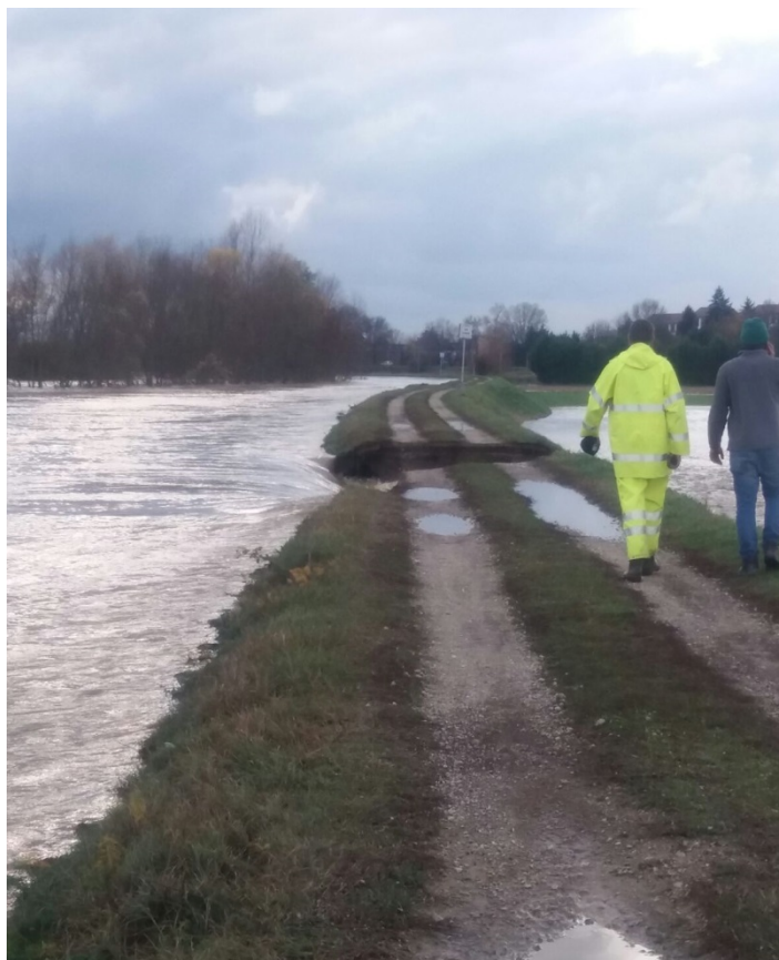
Foto 7 - 25/11/2016 h16:30: Rotta arginale a valle del ponte di strada Barauda su argine sinistro Vista da valle verso monte
