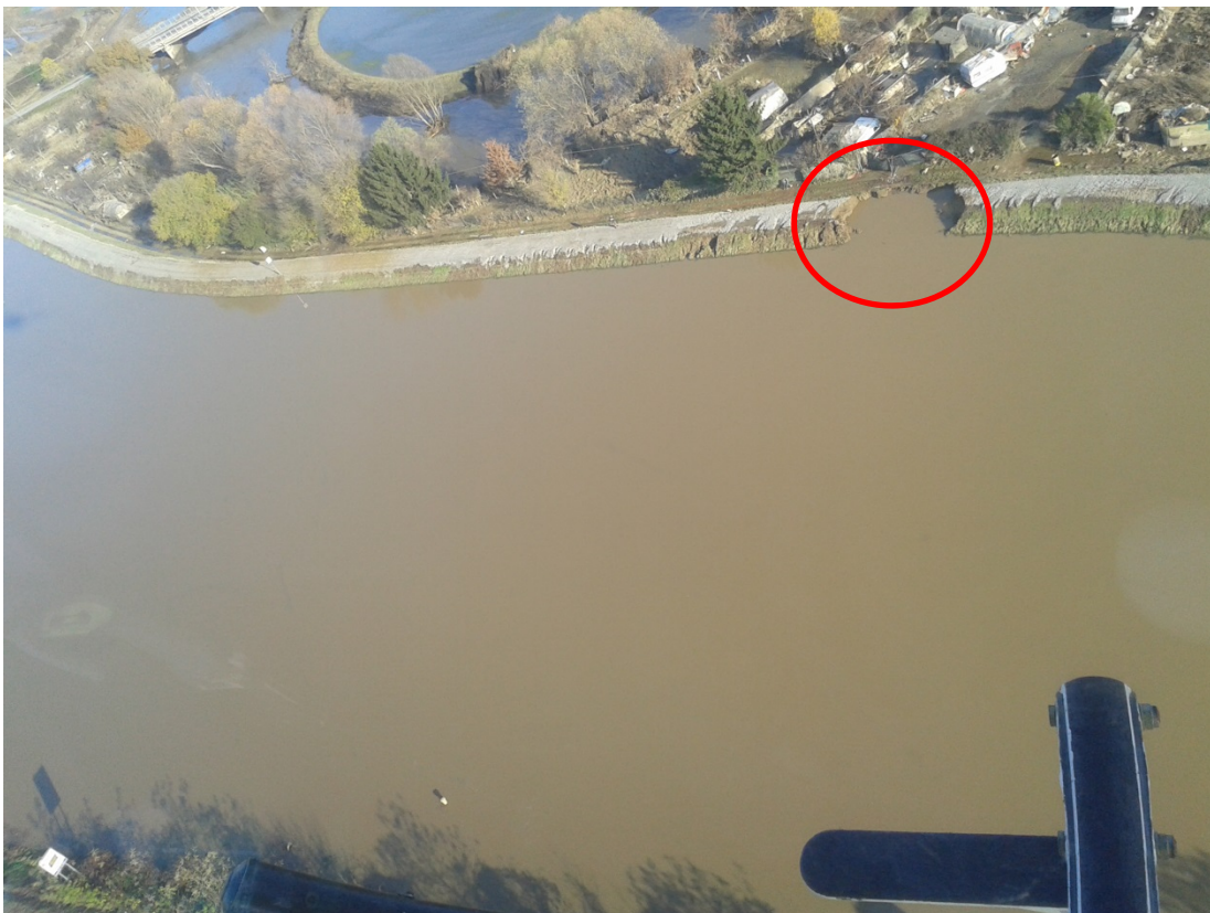
Foto 6 - 26/11/2016: Idem come sopra – Vista aerea
