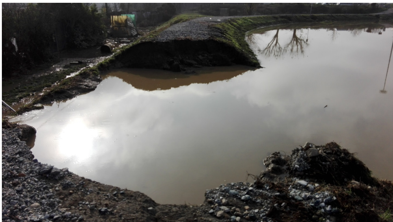
Foto 4 - 26/11/2016: Rotta arginale a monte del ponte di strada Barauda – Situazione al termine dell'evento
