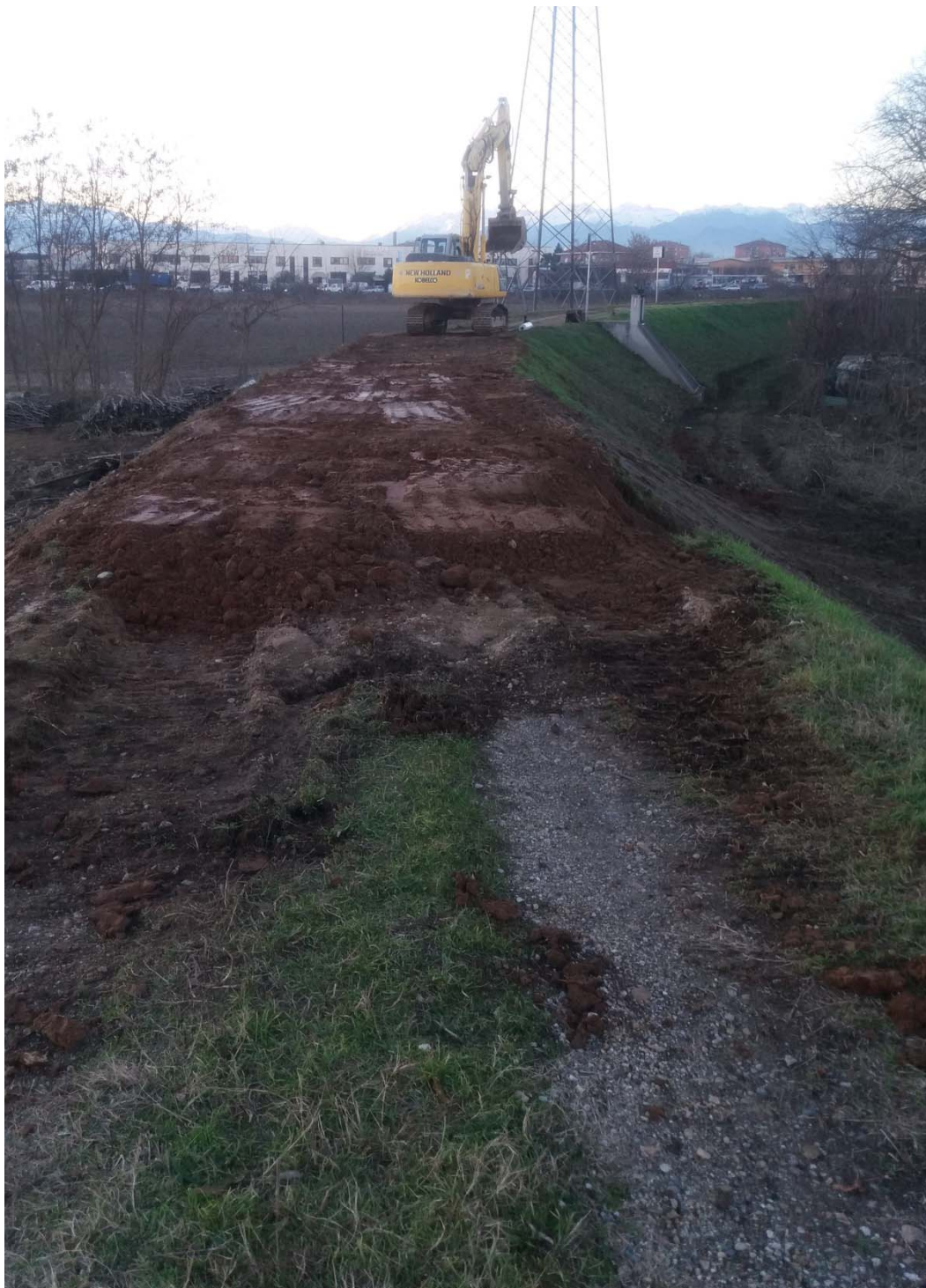
Foto 18 - 01/12/2016: Argine sinistro del T. Chisola, a valle del Ponte di strada Barauda, chiusura del varco Aperto per far defluire le acque comprese tra Strada Carignano e l'argine.
