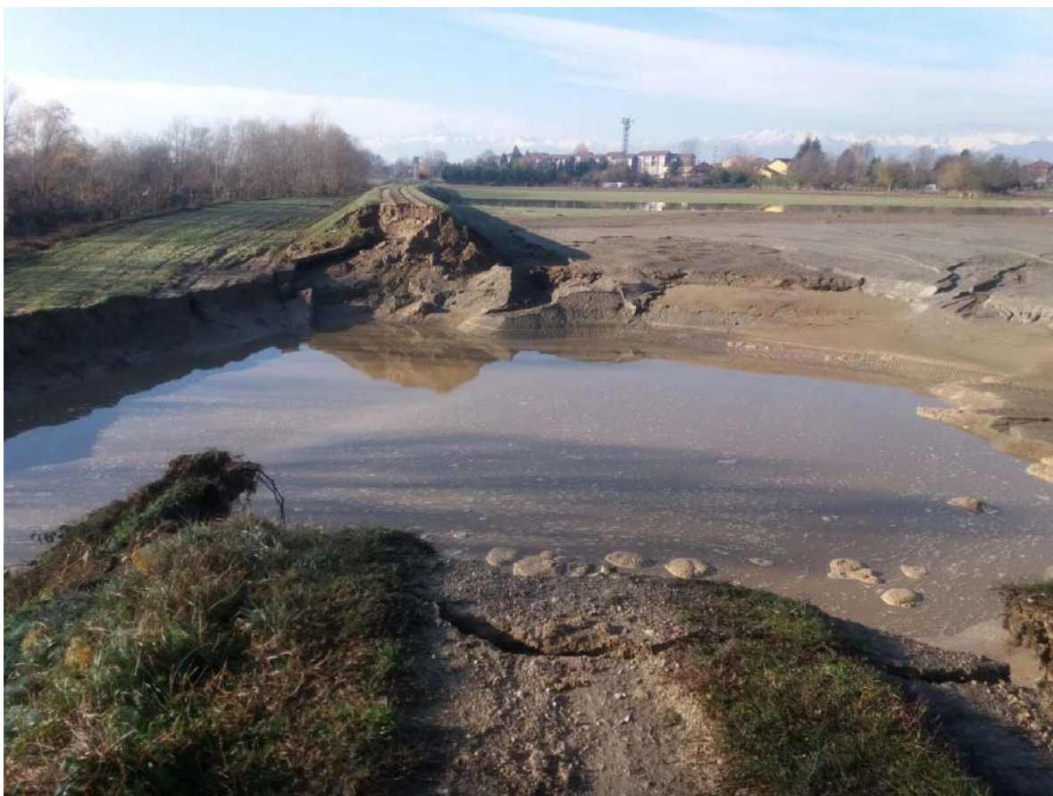
Foto 10 – 27/11/2016: Rotta arginale a valle del ponte di strada Barauda su argine sinistro Situazione in corrispondenza della breccia alla conclusione dell'evento.
