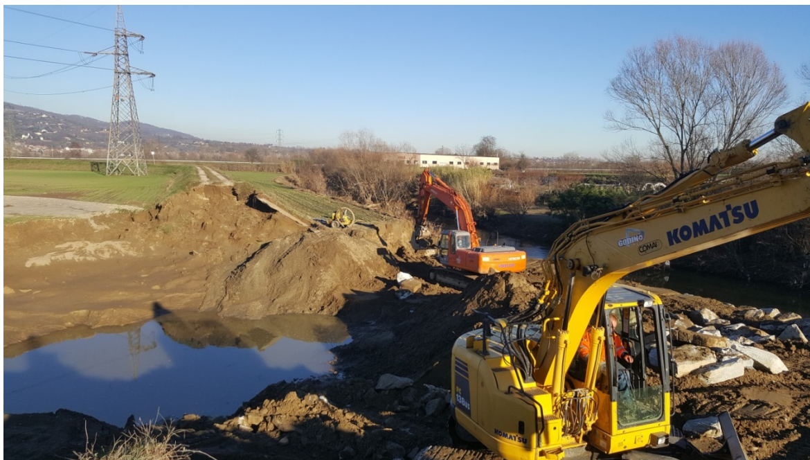
Foto 19 - 30/11/2016: Argine sinistro del T. Chisola, a valle del Ponte di strada Barauda, lavori di chiusura della rotta arginale.
