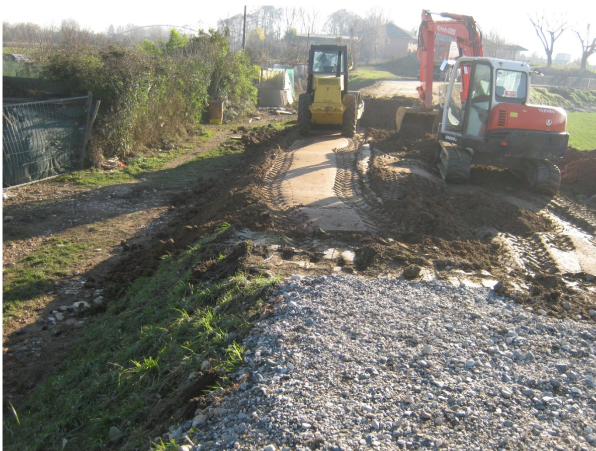
Foto 20 - 01/12/2016: Argine sinistro del T. Chisola, a monte del Ponte di strada Barauda, lavori di chiusura della rotta arginale.
