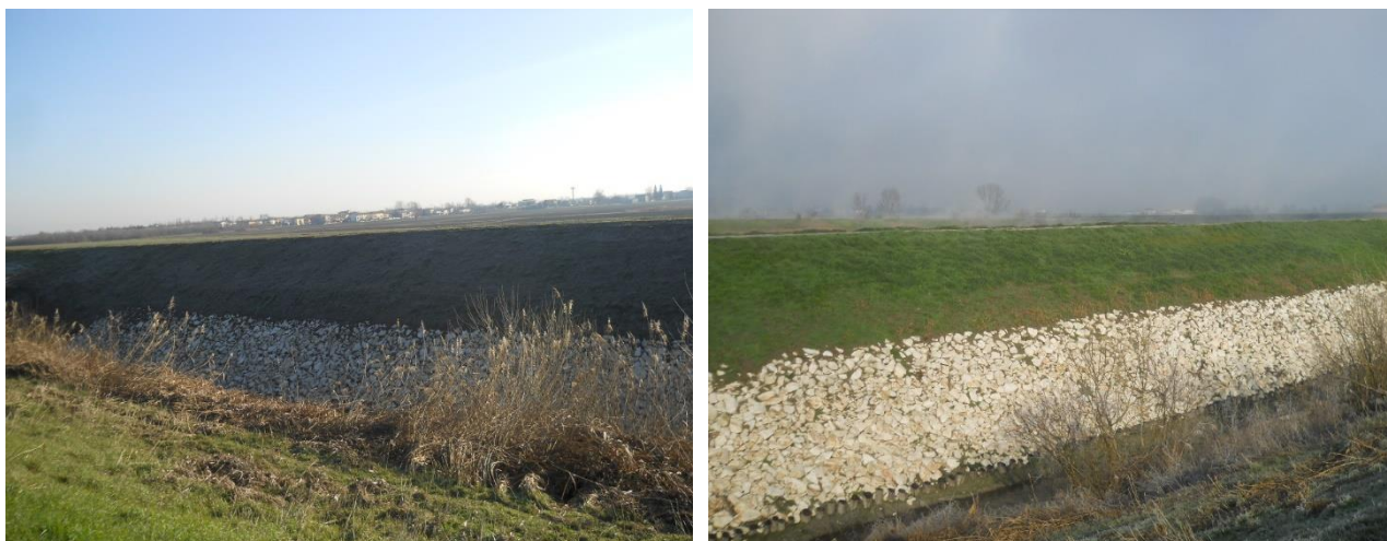
Figura 6 Difese spondali esistenti, in massi e palificate alla base
