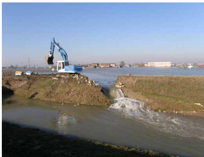
Realizzazione del primo taglio sul Cavo Argine a valle di via Chiaviche a Bastiglia
