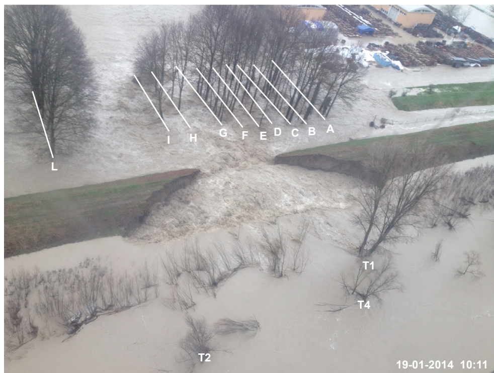
Figura 64 - Fotografia della breccia arginale presa dal Dott. Fabio Seghedoni alle ore 10:11 del 19-01-2014.
