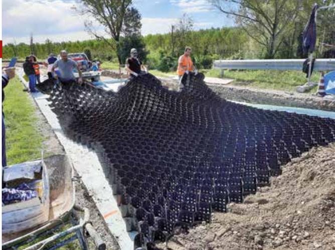
Foto 3: esecuzione lavori con posa di geostruttura
