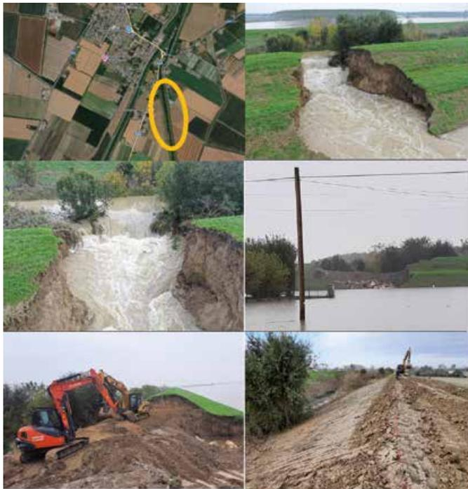
Figura 9: Rotta del Crostolo a S.ta Vittoria, ubicazione e fasi di intercettazione, chiusura e ricostruzione.
