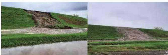
Figura 9: Rotta del Crostolo a S.ta Vittoria, ubicazione e fasi di intercettazione, chiusura e ricostruzione.
