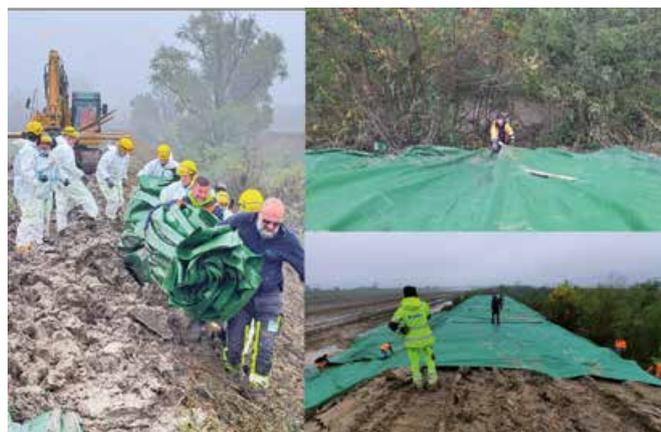
Figura 15 – telonatura delle chiusure di rotta – Cavo Cava
