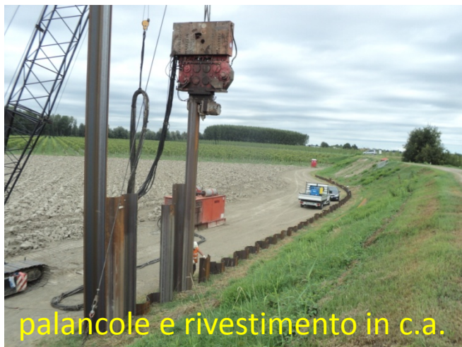
Cavezzo, Via Bozzala
