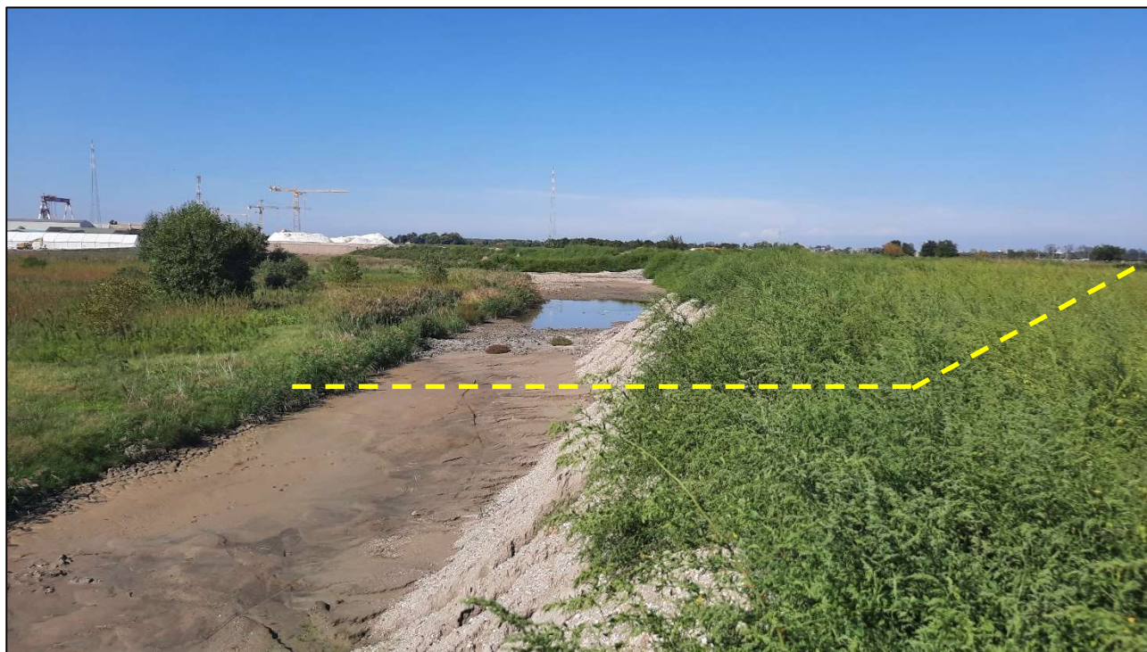
Figura 16 - Comune di Porto Viro – località Ca' Cappello – Destra idrografica del Po di Levante – Inserimento grafico schematico del profilo d'intervento sulla sommità arginale.
