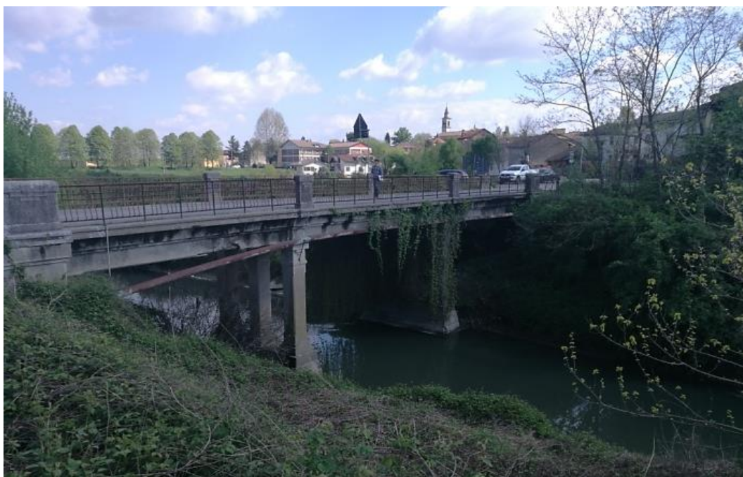
Barriere bordo ponte esistenti
