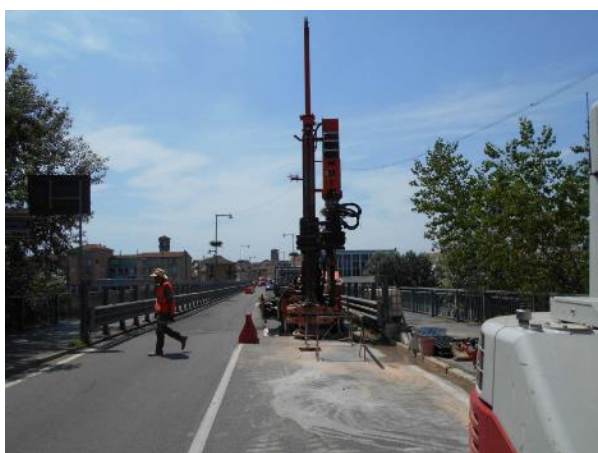
Fig. 4.5: Esecuzione sondaggi a carotaggio continuo verticali
