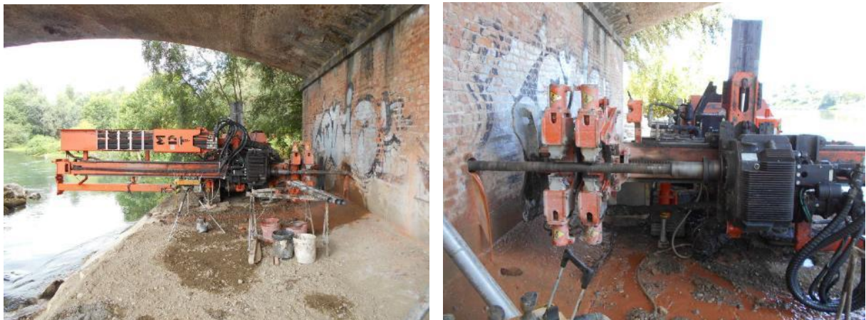
Fig. 4.3 – Esecuzione sondaggi a carotaggio continuo orizzontali
