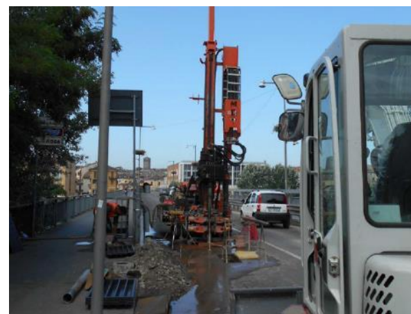
Fig. 4.5: Esecuzione sondaggi a carotaggio continuo verticali
