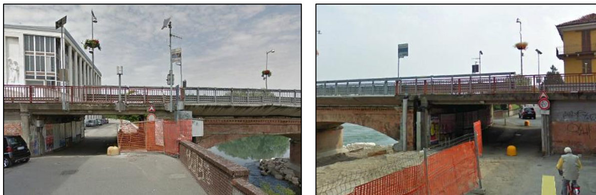
Fig. 5.6: Campata aggiuntiva in sponda destra – viste da valle (a sinistra) e da monte (a destra)
