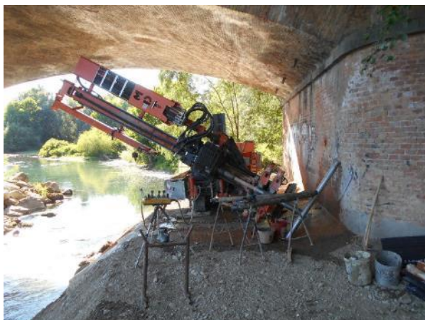
Fig. 4.3: Esecuzione sondaggi a carotaggio continuo inclinati
