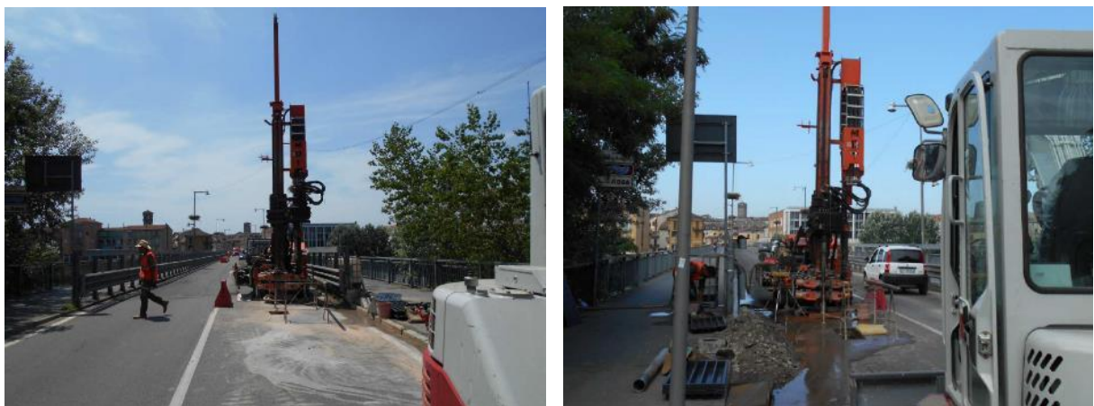
Fig. 4.4 – Esecuzione sondaggi a carotaggio continuo verticali
