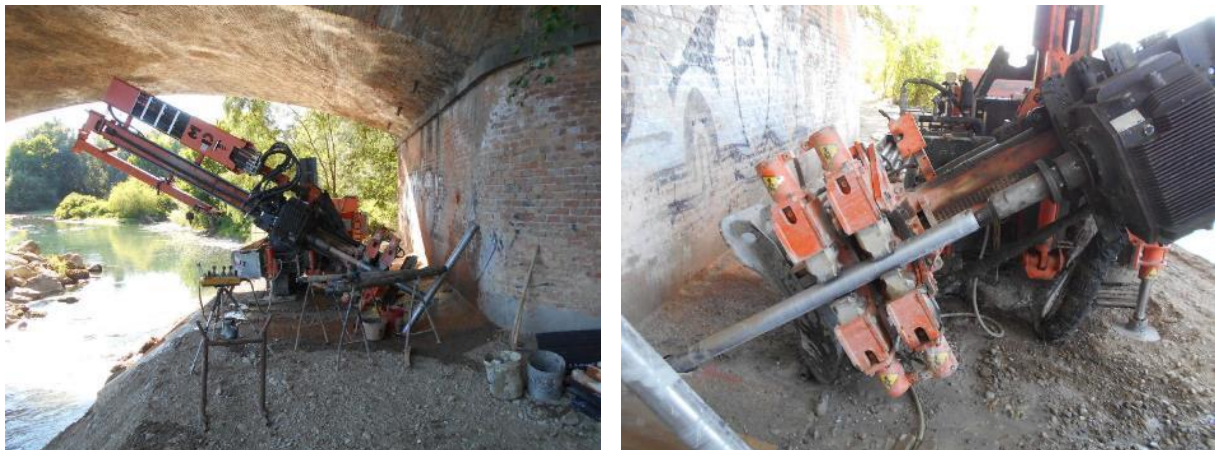
Fig. 4.2 – Esecuzione sondaggi a carotaggio continuo inclinati
