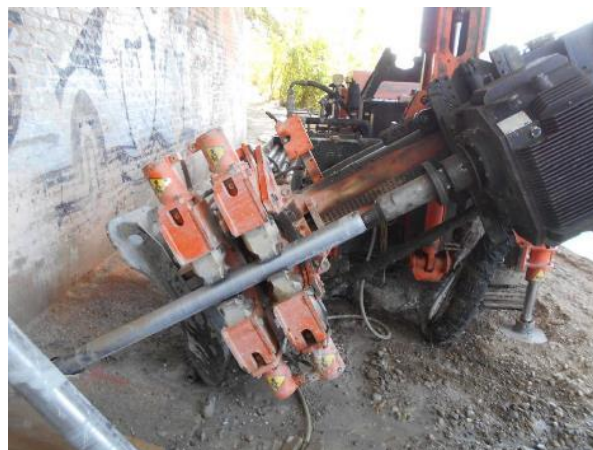
Fig. 4.3: Esecuzione sondaggi a carotaggio continuo inclinati
