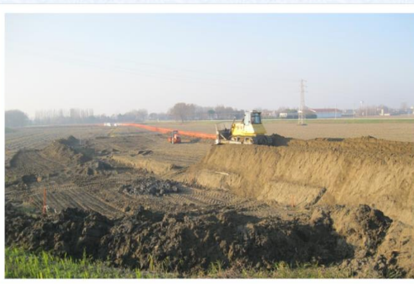
Nuovo argine attacco lato valle
