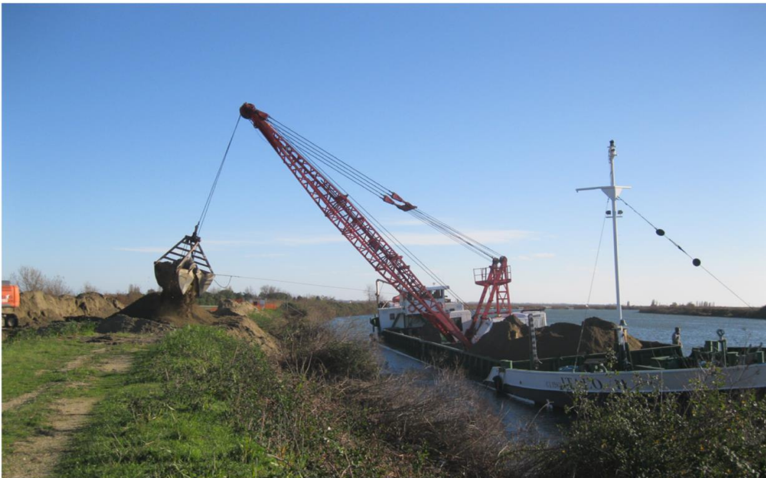
Scarico materiale sabbioso per la realizzazione sotto banca arginale
