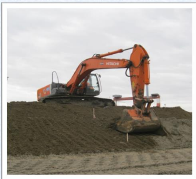
Nuovo argine attacco lato monte
