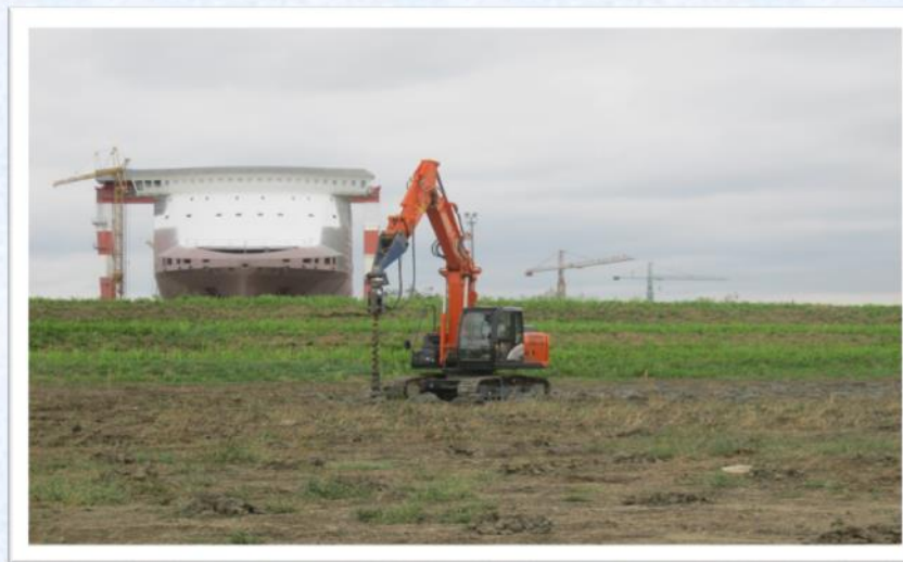
Trivellazione per bonifica bellica profonda
