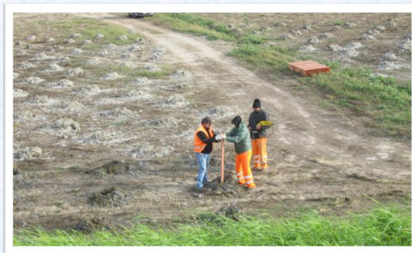
Bonifica bellica profonda
