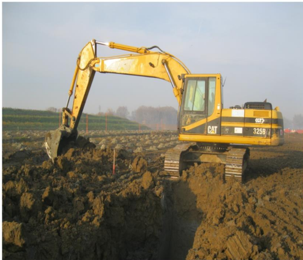
Fase di scavo taglione
