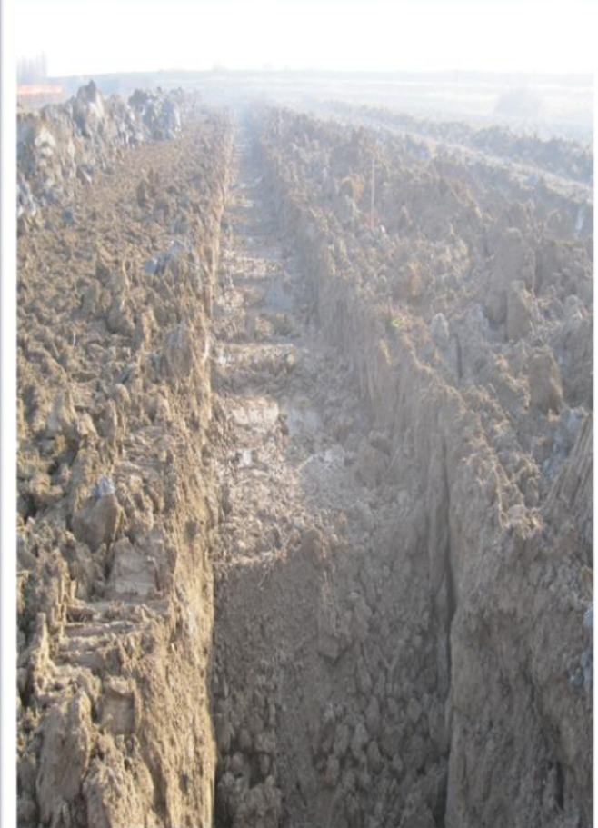
Realizzazione del taglione argilloso
