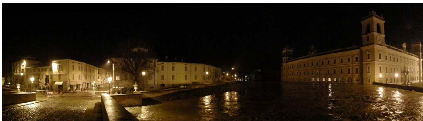
Fig. 7 Deflusso del colmo di piena al ponte storico di Colorno
