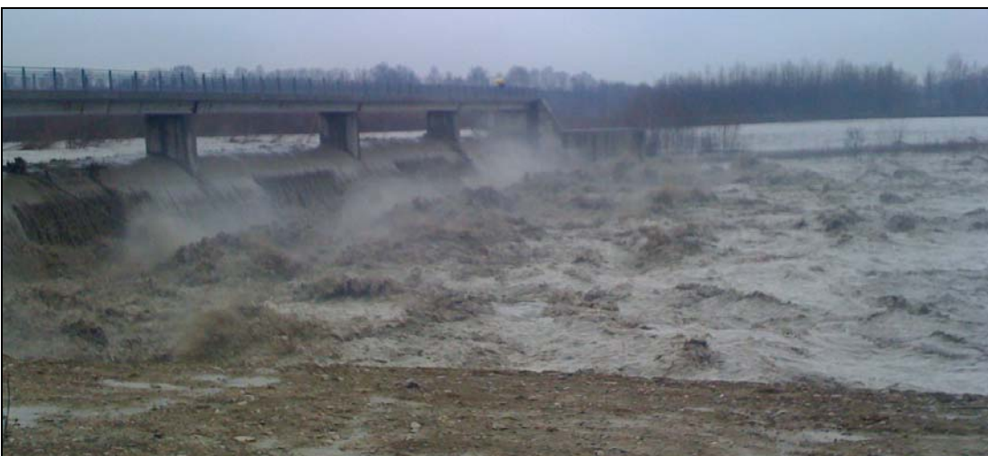
Fig. 3 Le Casse d’espansione dell’Enza – Cassa di monte: Manufatto limitatore in corso d’evento
