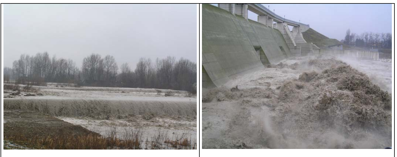
Fig. 5 La Cassa d'espansione del Parma: Traversa d'ingresso e Manufatto principale in corso d'evento.
